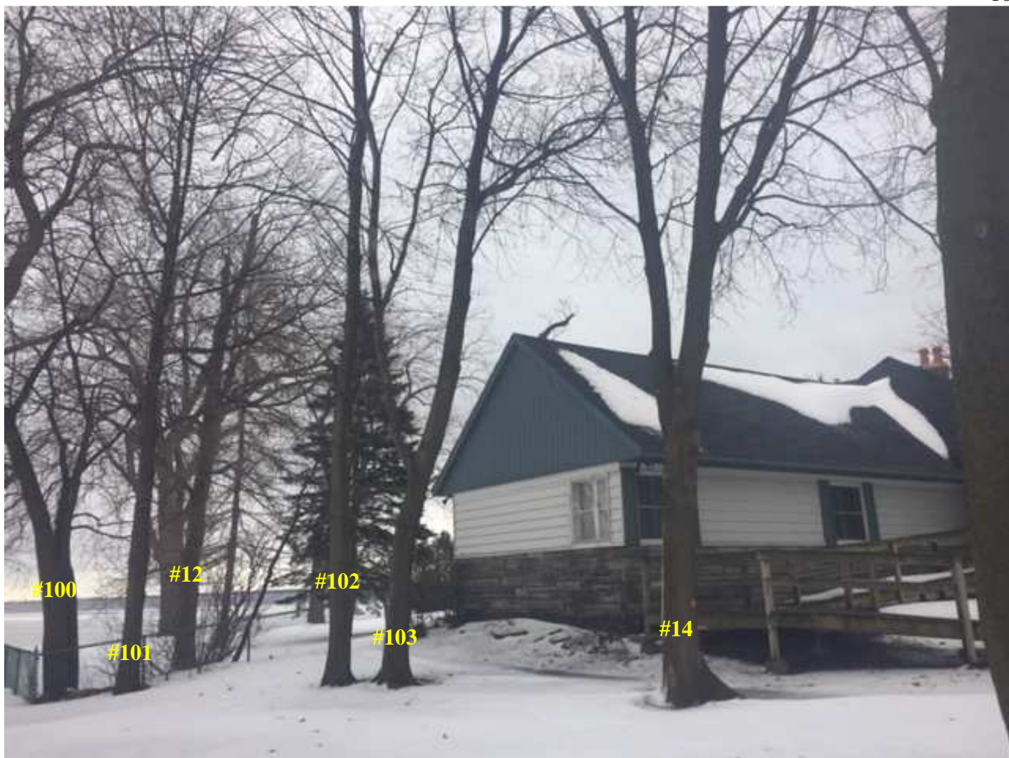
Photo #6 : Marge latérale Nord.
