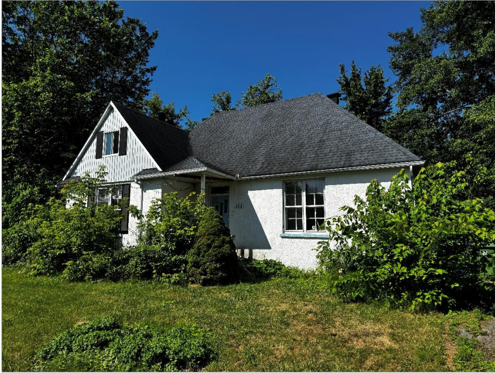
Façade du bâtiment
