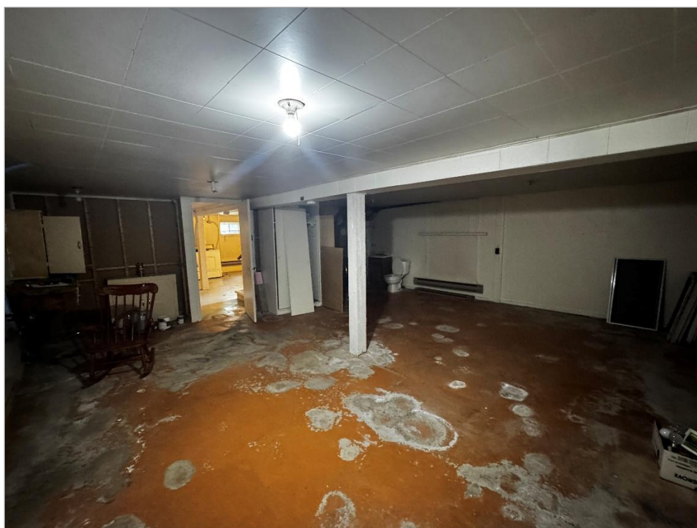
Sous-sol non fini
