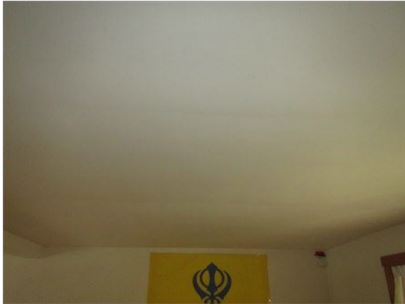
Gyplap ondulé au plafond du séjour
