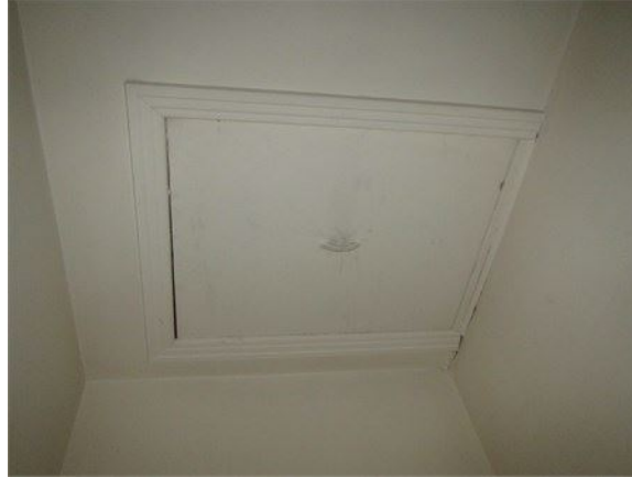
La trappe d'accès à l'entretoit au plafond de l'escalier du sous-sol
