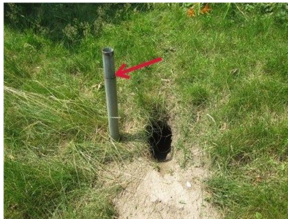
Conduite dans le sol de la cour arrière à expertiser / Noter le terrier adjacent
