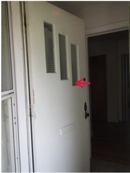
Porte d'entrée avant ancienne
