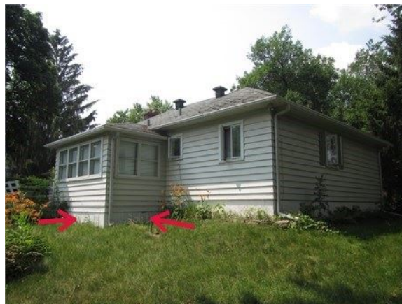
Fondations non visibles sous l'extension arrière
