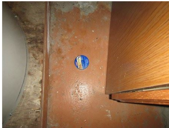
Trappe à fourmis au sous-sol près du chauffe-eau
