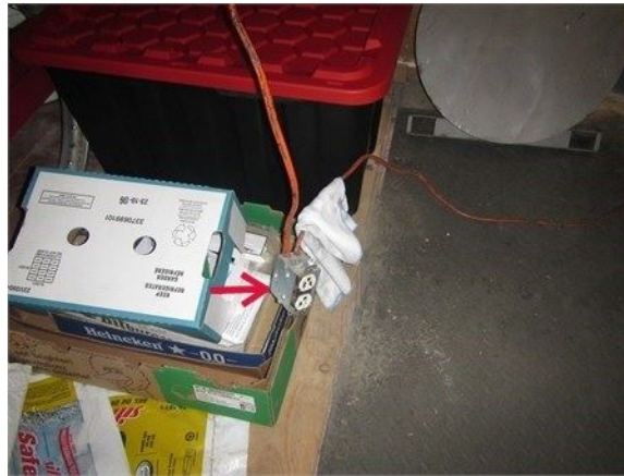
Prise à fixer au sous-sol
