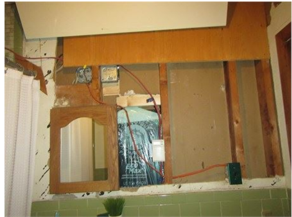
Travaux à compléter dans la salle de bains
