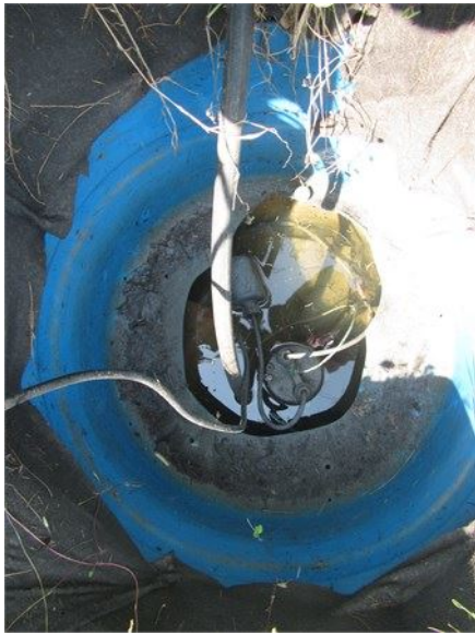
Le puits perdu dans la cour arrière, côté gauche
