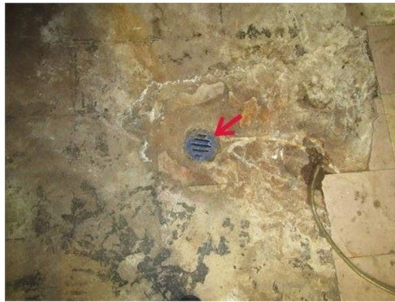
Le drain de plancher au sous-sol
