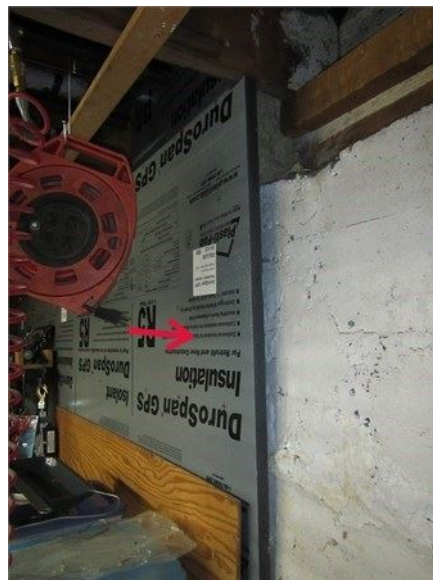
La plupart des murs de fondation ne sont pas isolés, seul un panneau de R-5 a été observé sur le mur latéral droit du sous-sol
