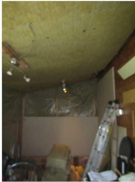
Travaux à compléter dans la salle à manger à l'arrière
