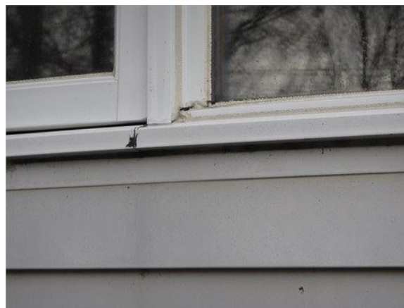
Les menuiseries ne sont plus étanches. Il en est de même pour les garnitures d'étanchéité
