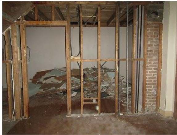
Exemple de dégarnissage et matériaux de démolition au sol
