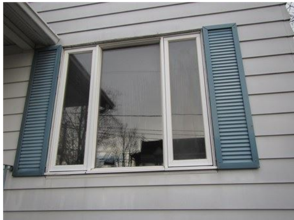
Exemple de fenêtre à remplacer
