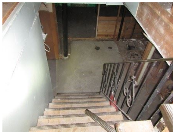
Marches de l'escalier du sous-sol en tuiles
