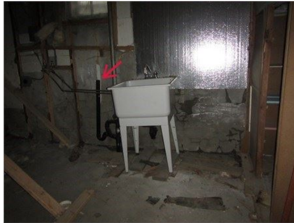
Sceller l'extrémité de la conduite de la machine à laver
