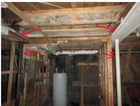
Les deux poutres en bois et certains des poteaux en acier
