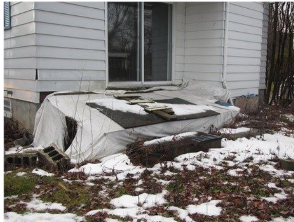
La terrasse arrière a été démolie
