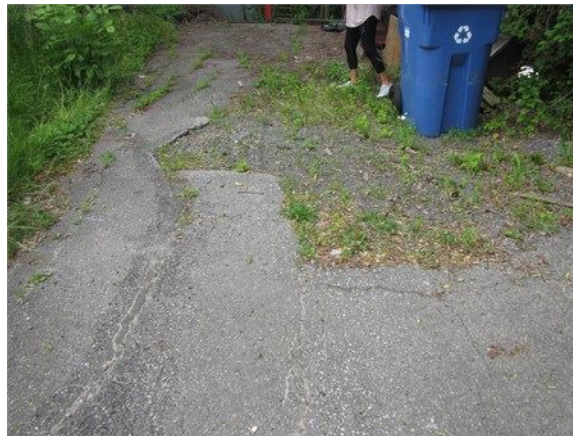
Entrée d'asphalte en très mauvais état
