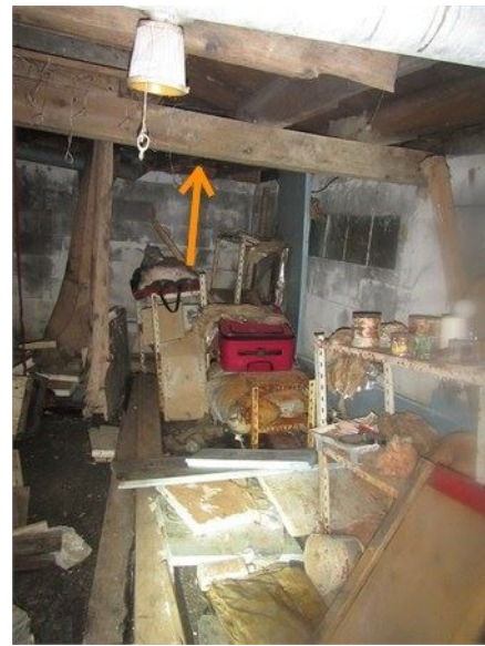
Poutre faible dans le vide sanitaire
