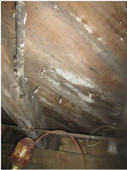
Taches sur la structure qui pourrait comporter des moisissures dans le vide sanitaire
