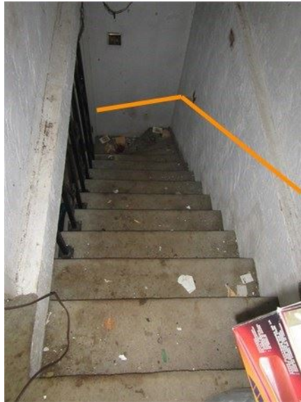
Installer une main courante dans l'escalier de l'étage
