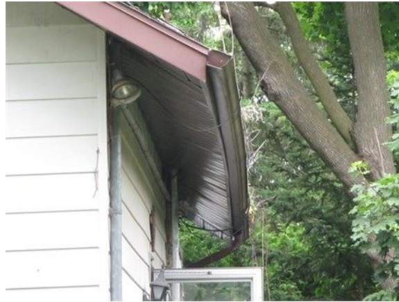
Structure de toit arquée dans les soffites du côté droit
