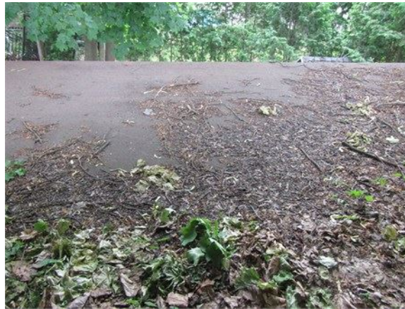
Nettoyer la couverture de l'extension arrière
