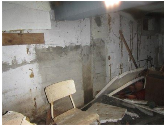
Exemple de mur de fondation sans isolation
