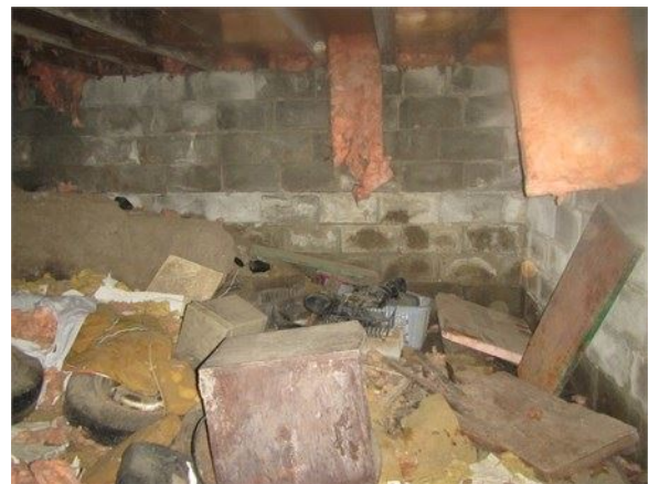
Fissures sur le mur arrière, côté droit
