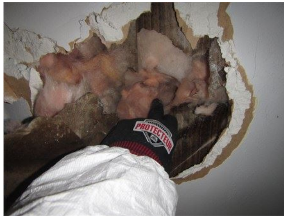
Laine minérale dans le plafond de la chambre avant de l'étage
