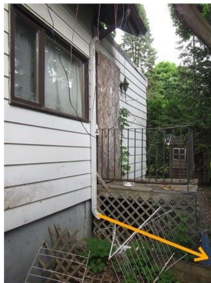
Installer des exutoires de gouttières
