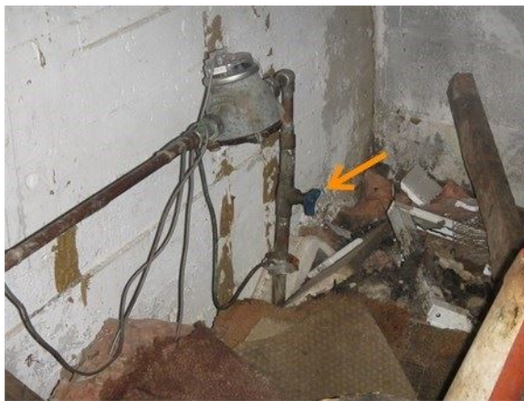
L'entrée d'eau principale dans le vide sanitaire sur le coin avant droit
