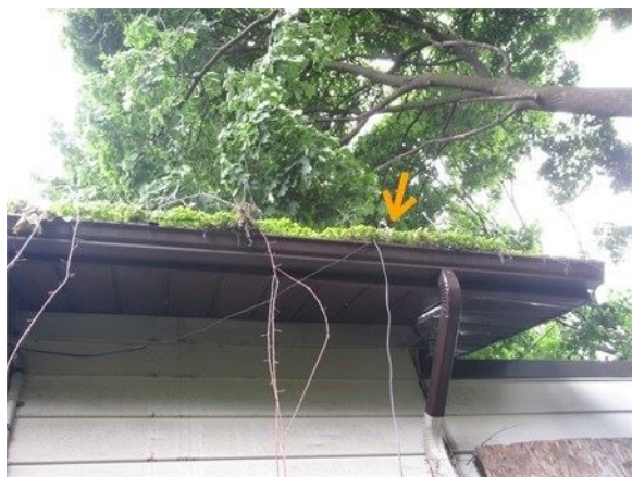
Nettoyer les gouttières
