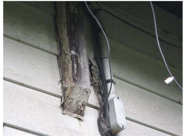
Revêtement qui est découpé autour des mâts électriques
