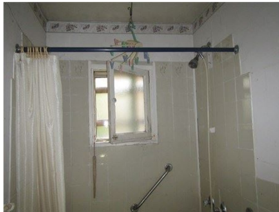
Fenêtre dans la douche
