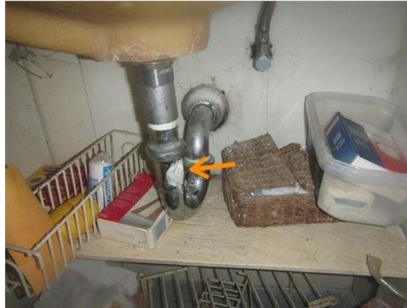
Siphon qui commence à percer sous le lavabo
