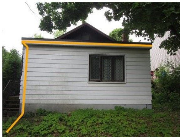
Installer une gouttière sur le débord de toit arrière
