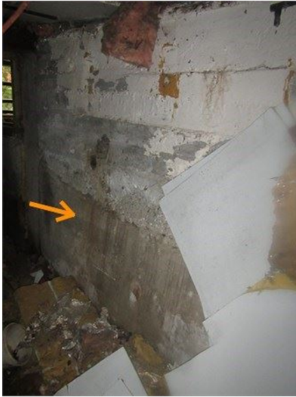
Traces d'infiltration d'eau entre deux sections de béton coulé
