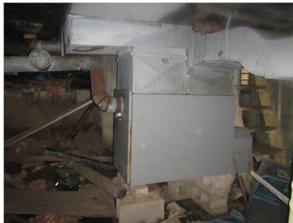
La fournaise au mazout dans le vide sanitaire
