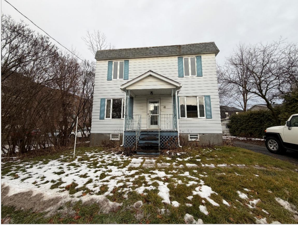
Vue avant du bâtiment
