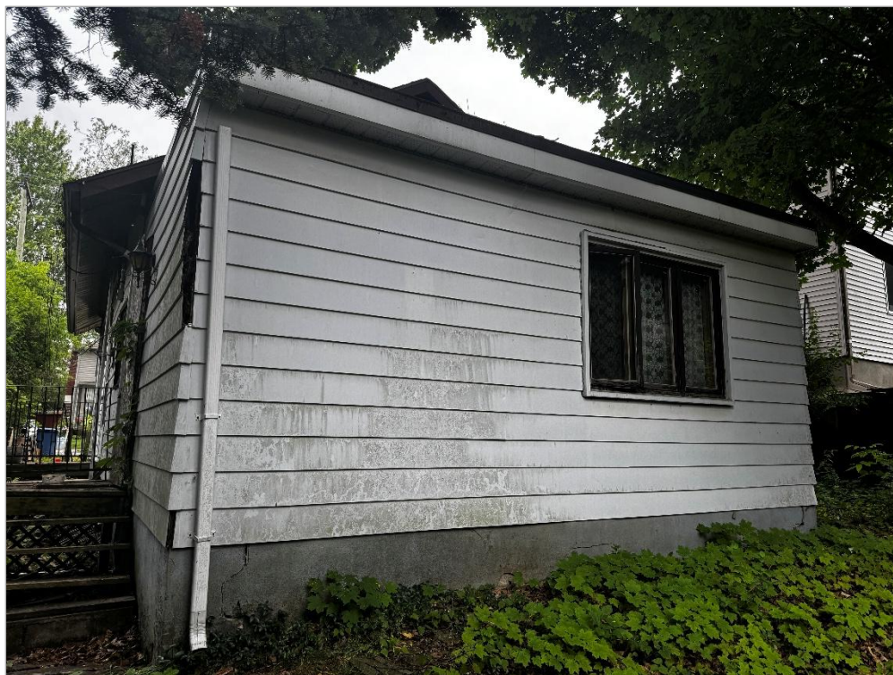
Vue arrière du bâtiment
