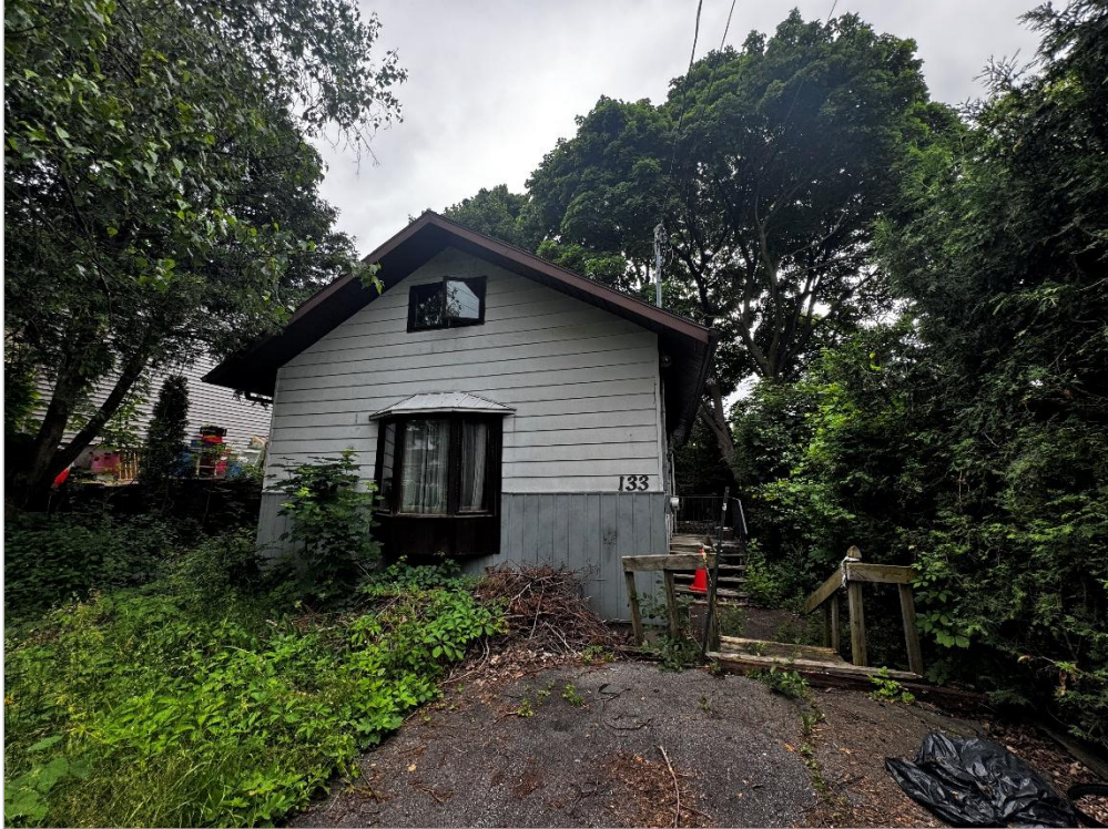
Vue avant du bâtiment
