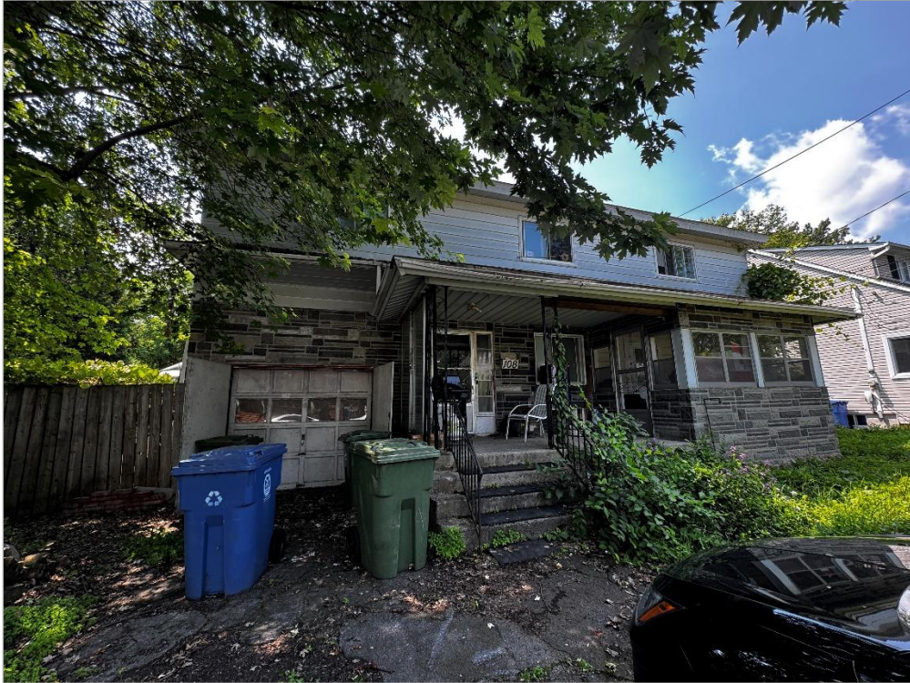
Façade du bâtiment
