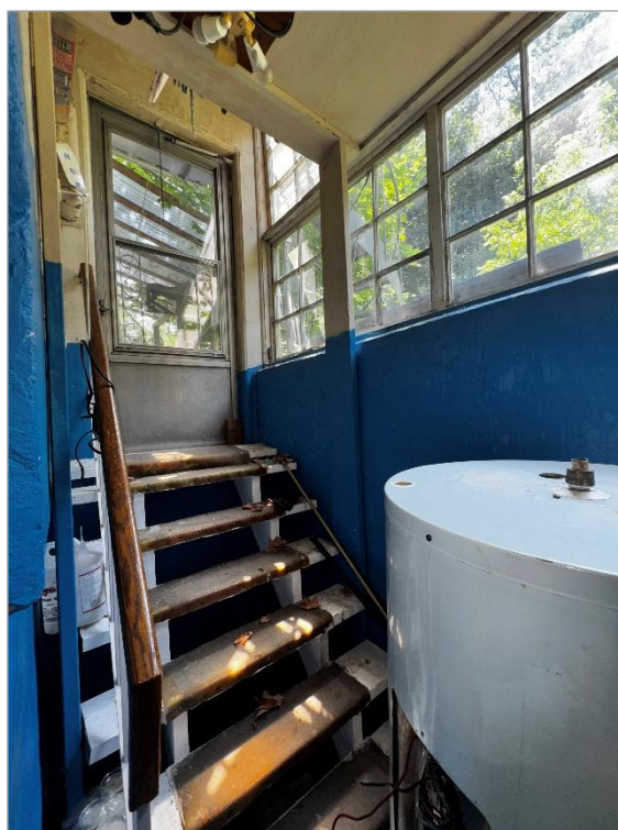
Entrée extérieure menant au sous-sol
