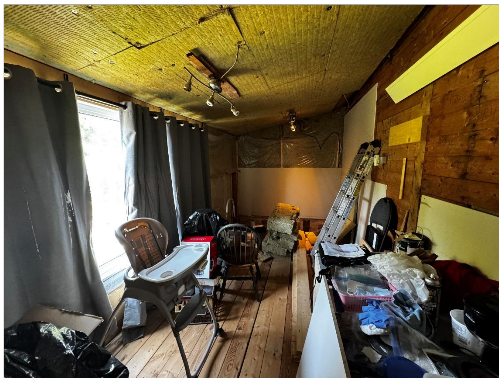
Salle à manger (en cours de rénovation)
