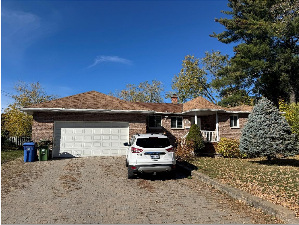
Façade du bâtiment
