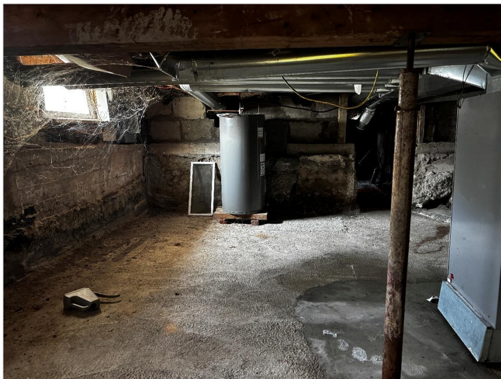
Sous-sol de service (accessible par le logement 38, Saint-Joachim)
