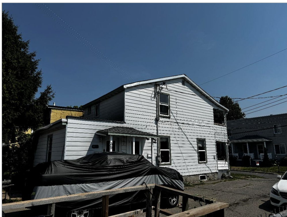
Vue latérale gauche du bâtiment
