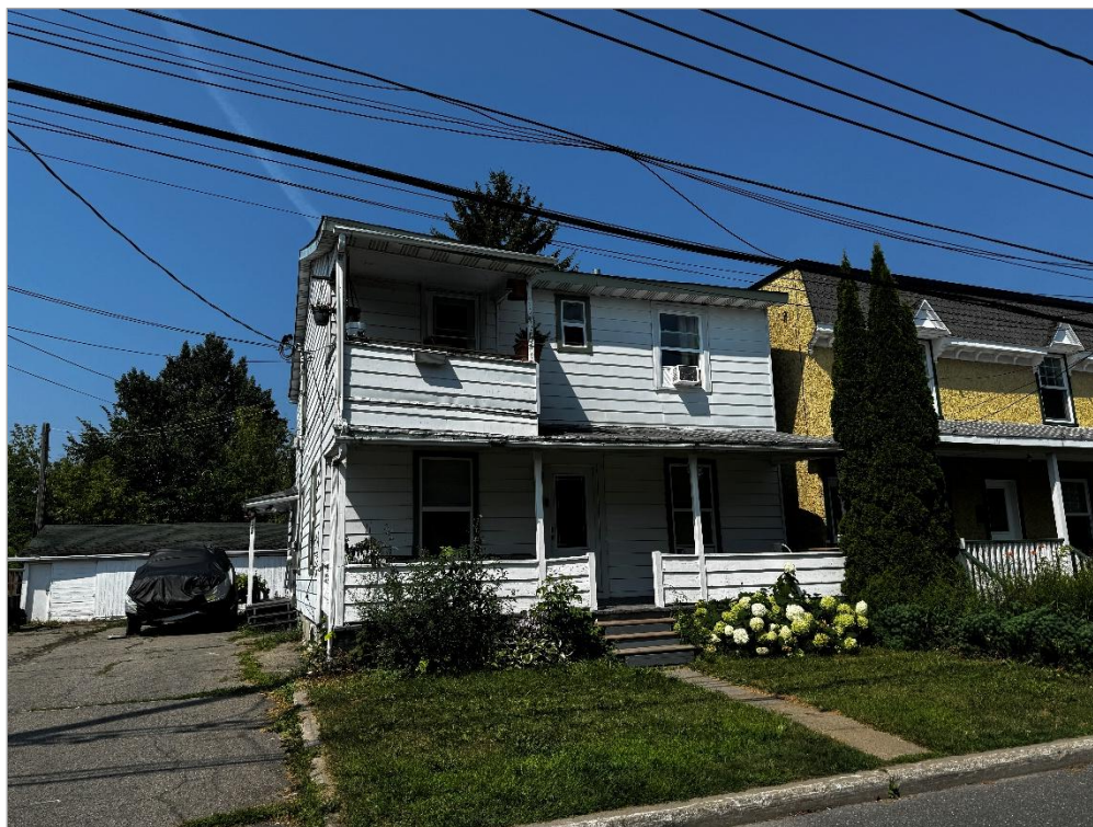
Vue avant du bâtiment
