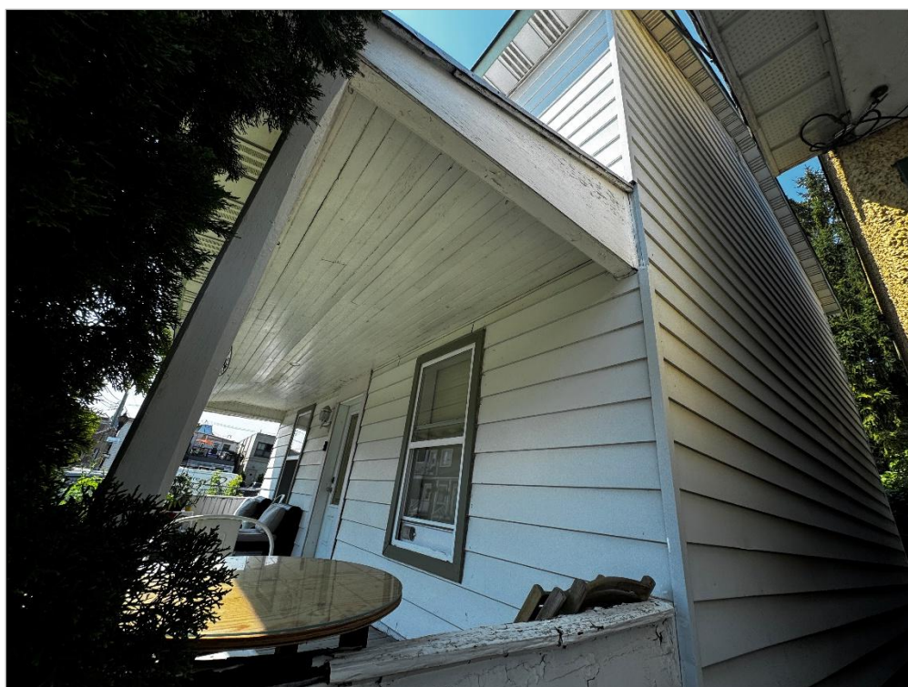
Vue latérale droite du bâtiment
