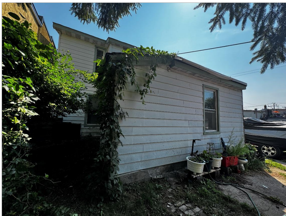
Vue arrière du bâtiment
