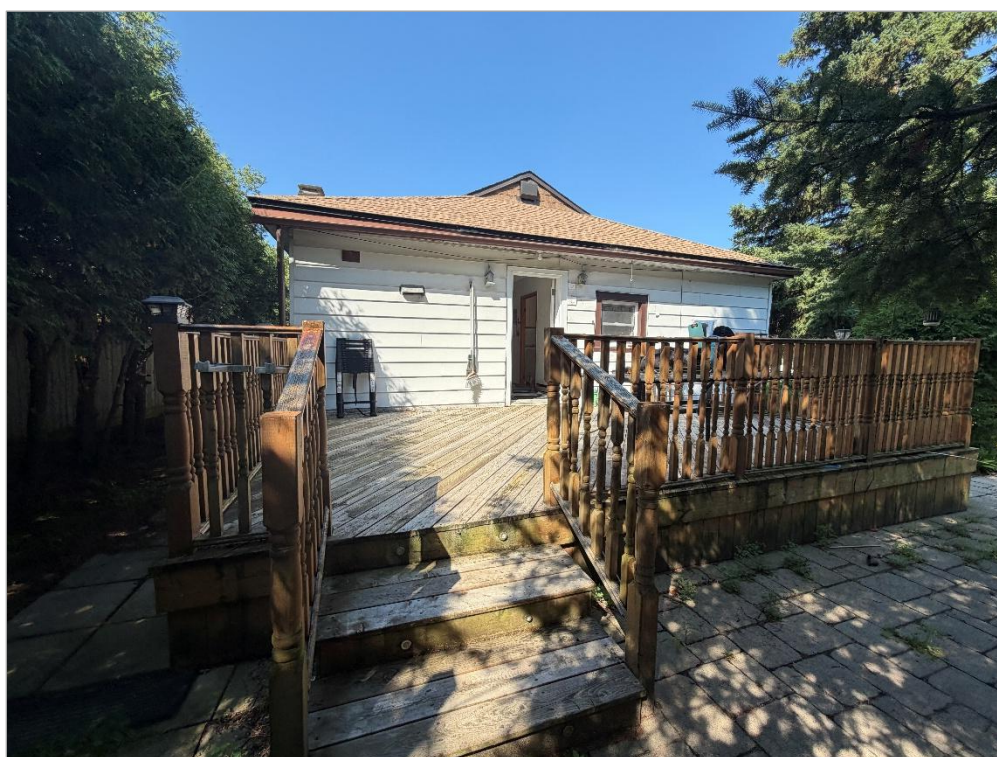
Vue arrière du bâtiment
