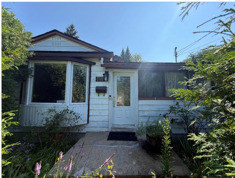
Vue avant du bâtiment
