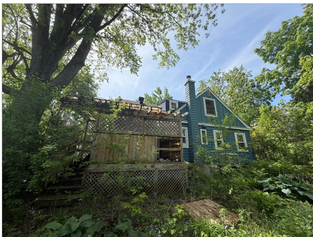
Vue arrière du bâtiment
