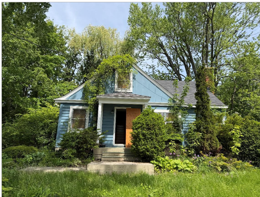
Vue avant du bâtiment
