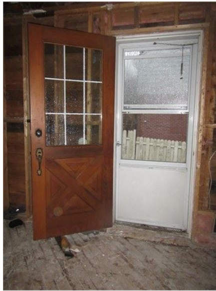
Vieille porte en bois avec contre-porte en aluminium
