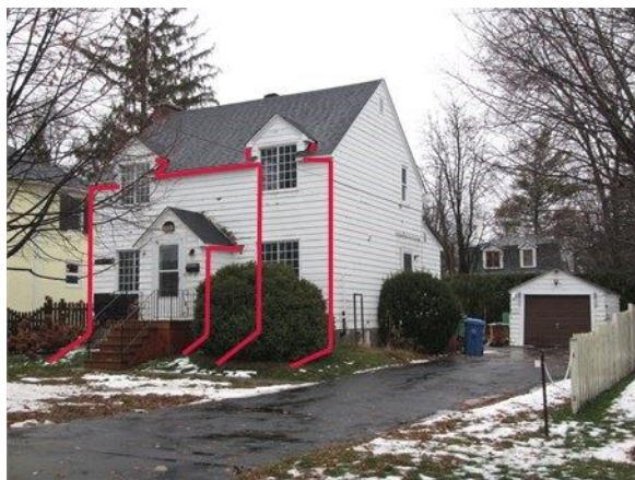
Installer des gouttières sur les pentes de toit avant
