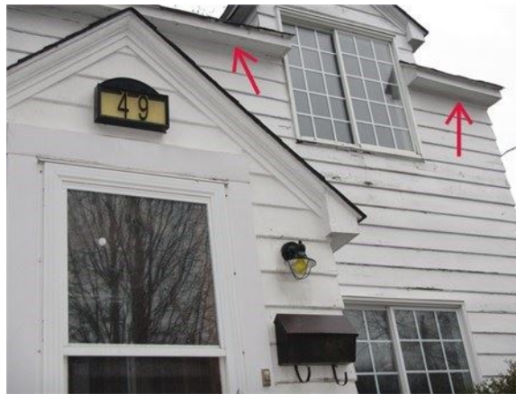
Soffites restreints sur le débord de toit avant
