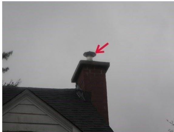
Chemisage intérieur de la cheminée
