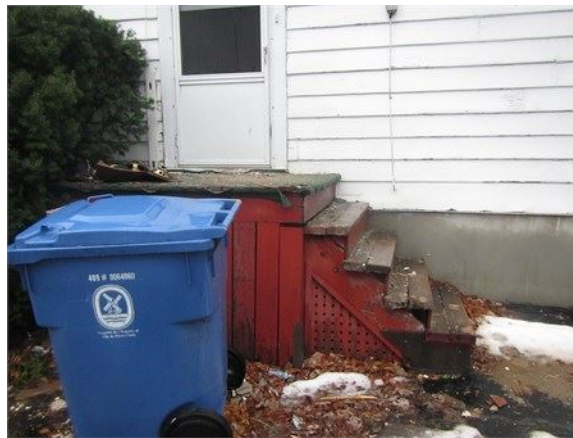
Le perron latéral et son escalier sans main courante et sans garde-corps
