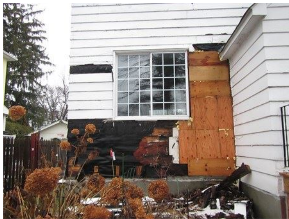
Revêtement extérieur remplacé partiellement et temporairement
