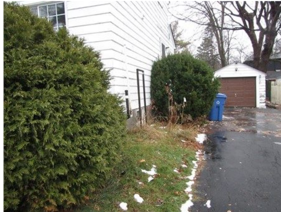
Exemple d'arbuste trop près du bâtiment
