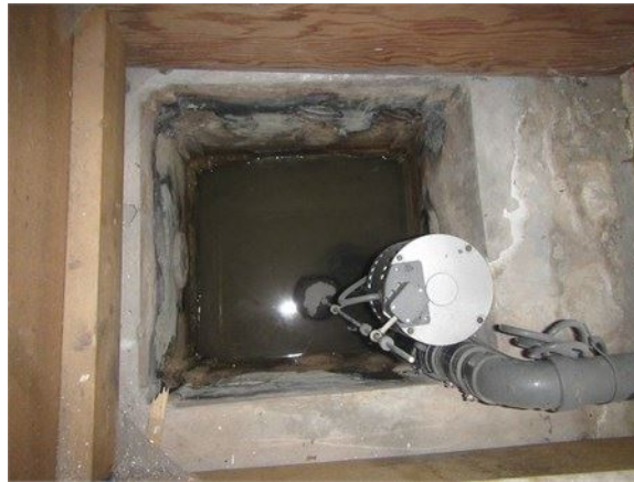
Le puisard dans le sous-sol
