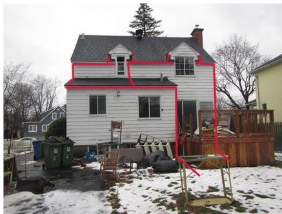
Installer des gouttières sur les pentes arrière
