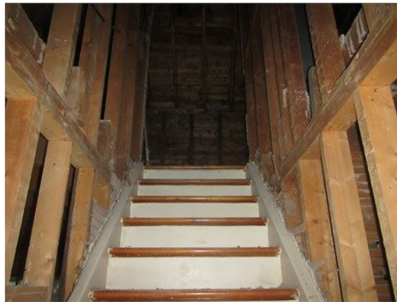
L'escalier de l'étage laissé en place
