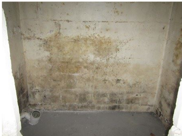
Taches qui pourraient comporter des moisissures sur des murs de fondation
