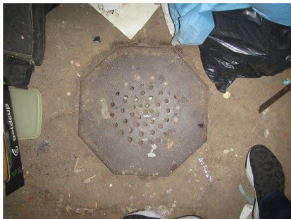
Grille sur la dalle du garage
