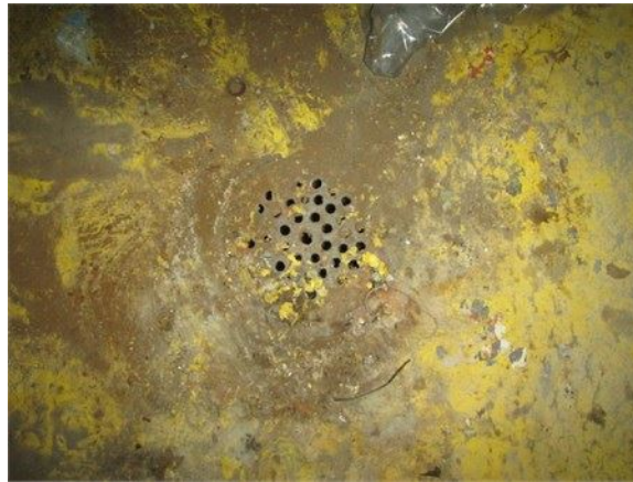
Vieux drain dans le sous-sol
