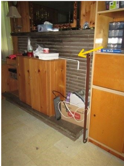
Ancien foyer de maçonnerie visible au rez-de-chaussée
