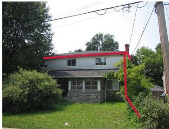
Installer des gouttières sur les débords de toit principaux
