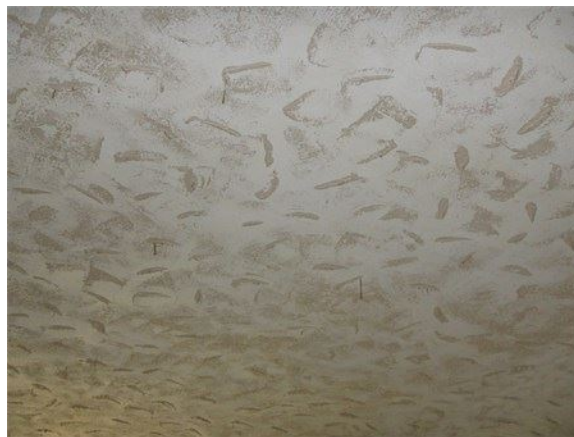
Stuc au plafond d'une partie du rez-de-chaussée
