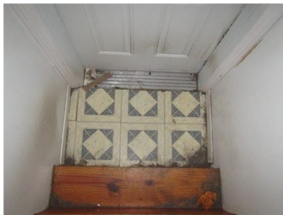
Palier au bas de l'escalier avant droit de l'étage étroit
