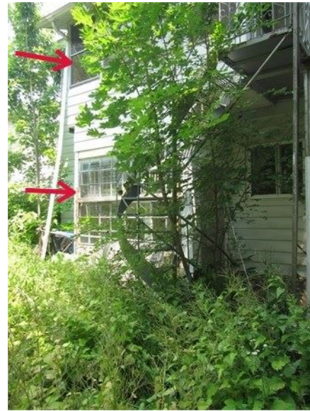
L'extension arrière de la descente du sous-sol et de la véranda arrière de l'étage
