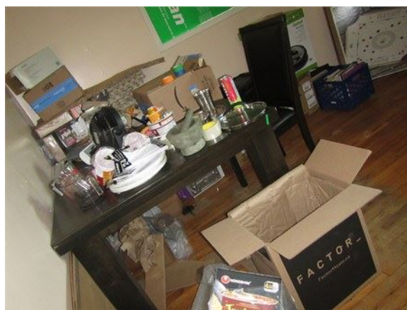
Le plancher de la chambre avant droite de l'étage penche vers la droite
