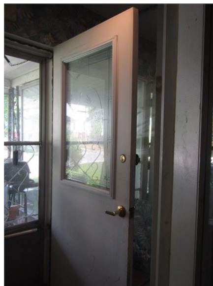
Porte d'entrée avant en bois avec contre-porte
