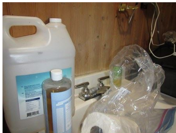
Absence de prise près du lavabo de la salle de bains de l'étage
