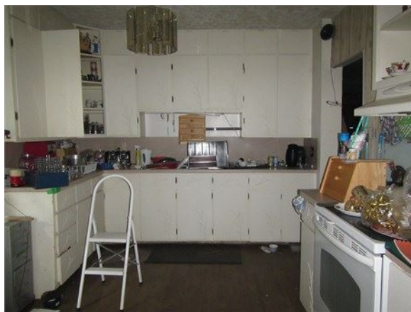
La cuisine ancienne du rez-de-chaussée
