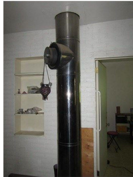
Conduit de fumée visible au rez-de-chaussée
