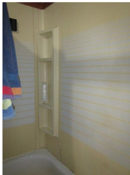
Panneaux préfabriqués autour de la baignoire de l'étage
