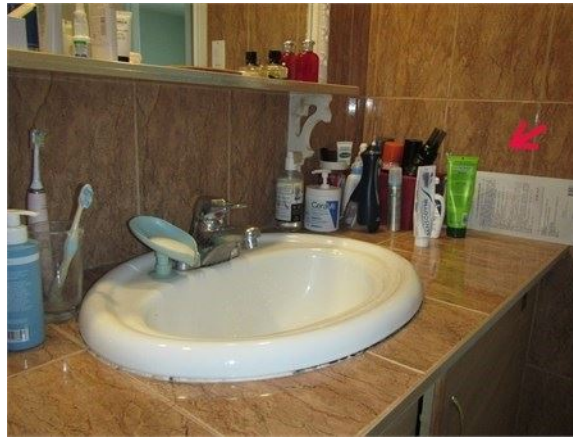
Absence de prise près du lavabo dans la salle de bains
