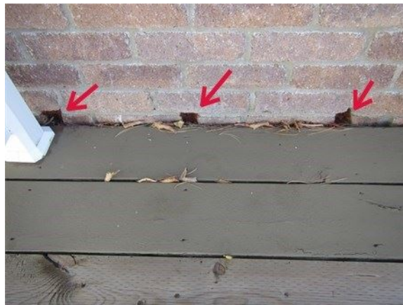
Refermer rapidement les ouvertures dans le mur arrière
