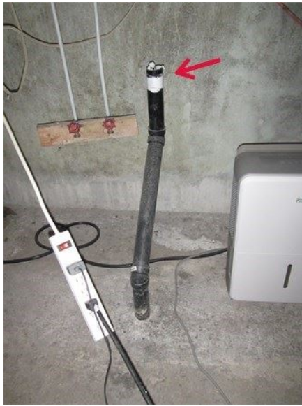
Conduite abandonnée à sceller au sous-sol
