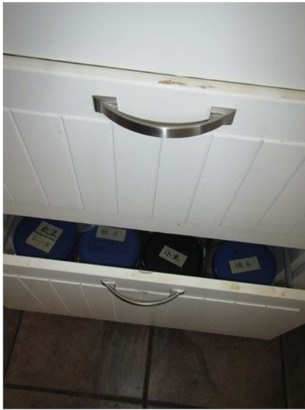
Devanture de tiroirs à réparer sur des armoires de la cuisine
