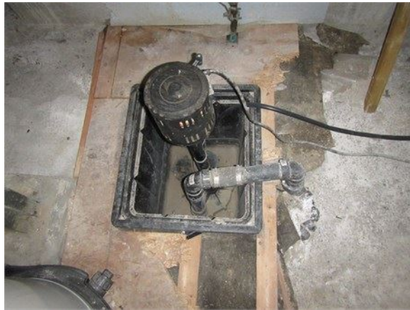
Le puisard du sous-sol : Installer un couvercle sur le puisard
