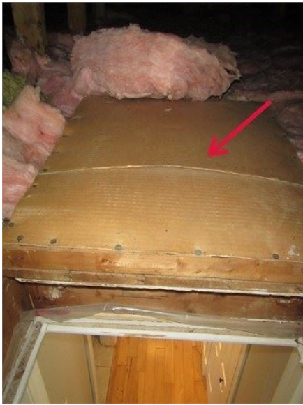
Trappe de la maison à mieux isoler
