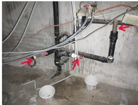
Autres conduites à sceller au sous-sol
