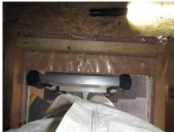
Installer un coupe-froid autour de chaque trappe d'accès à l'entretoit
