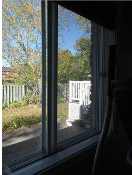
Exemple de vieille fenêtre coulissante en PVC
