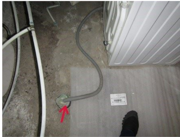
Conduite d'évacuation flexible connectée directement à une conduite dans la dalle sans siphon
