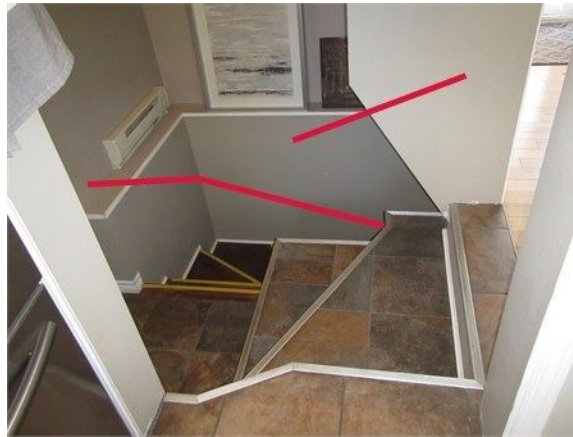
Installer des mains courantes dans l'escalier
