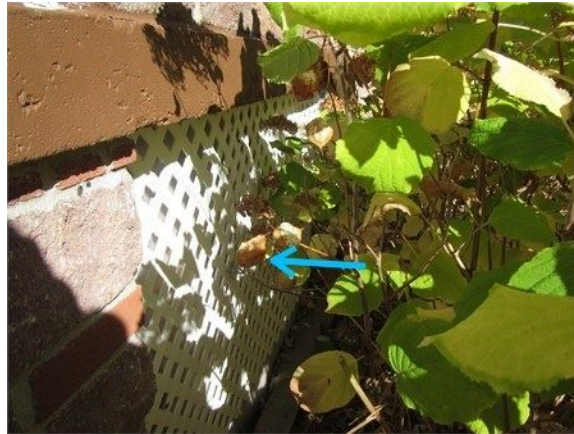
Ouverture refermée sur le mur avant et près du sol
