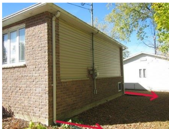
Installer des exutoires plus long au bout des descentes pluviales
