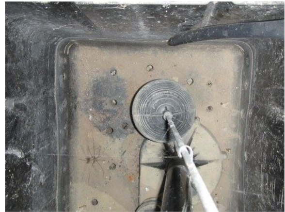
Le fond du puisard est percé pour recueillir les eaux souterraines
