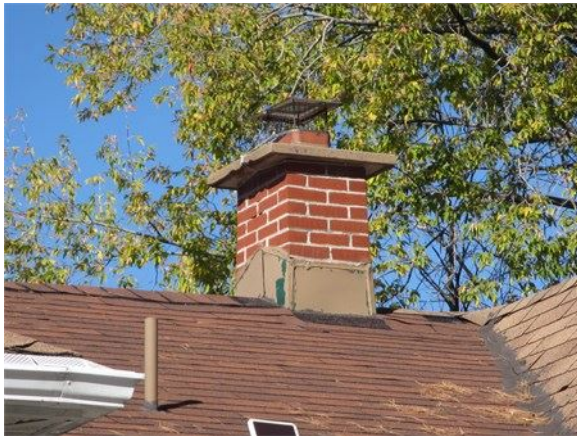
La cheminée abandonnée sur le toit
