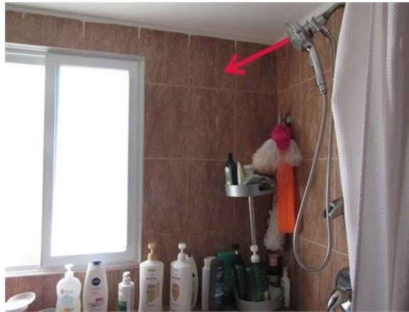
Douche dans la fenêtre de la salle de bains, ce qui n'est pas souhaitable
