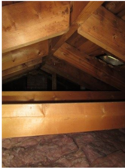
Exiguïté de l'espace de l'entretroit principal
