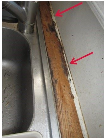
Enlever le scellant et poncer le comptoir de bois avant de le revernir
