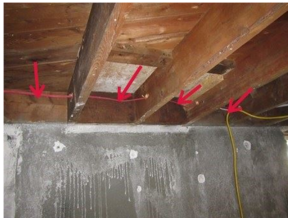
Exemple de solive de rive non isolée
