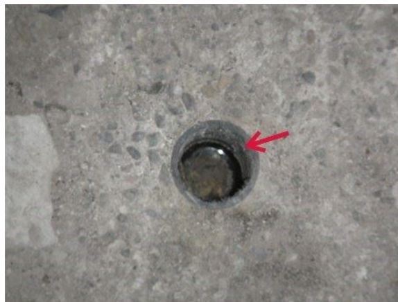
Installer une grille sur le drain du sous-sol
