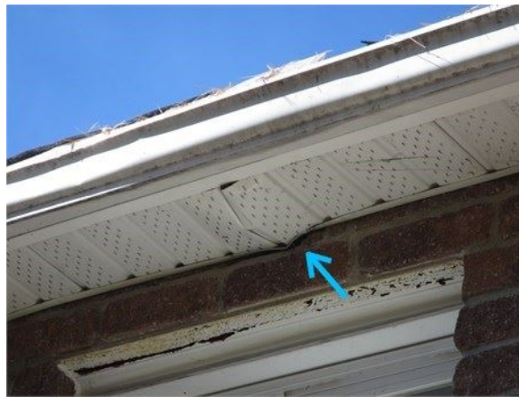
Soffites à fixer en place
