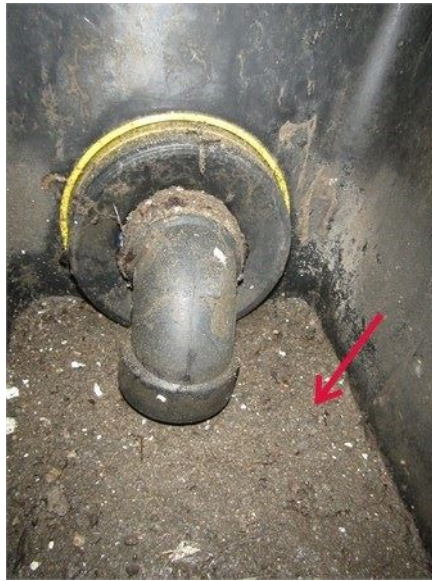
La fosse de retenue à nettoyer dans le garage
