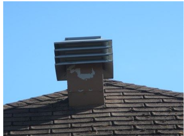
L'aérateur surélevé sur la pente arrière du garage
