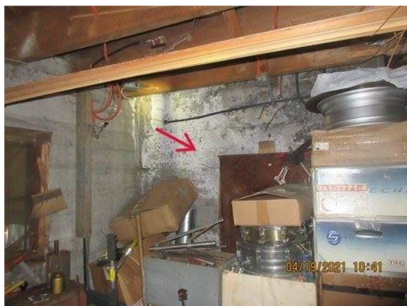
De l'efflorescence a été observée sur la dalle de béton et sur les surfaces verticales
