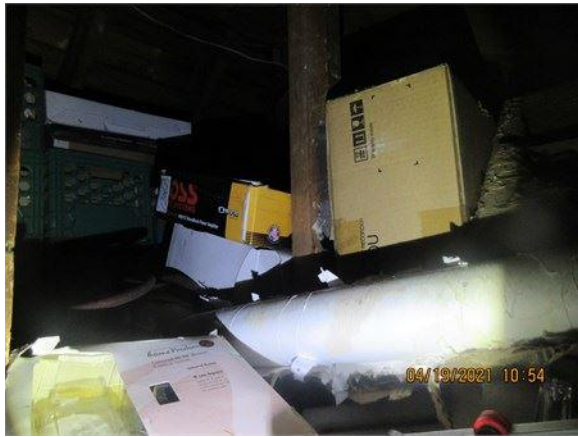
Vue de l'entreposage dans le vide sous-toit
