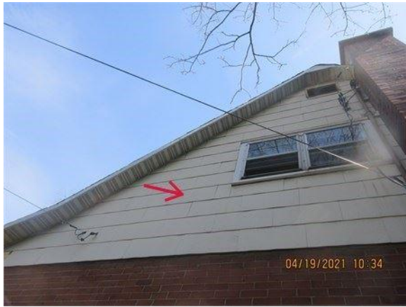
Vue du revêtement de bardeaux sur l'élévation droite
