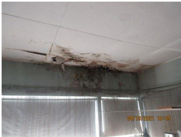
Vue des dégâts des infiltrations d'eau au r.d.c
