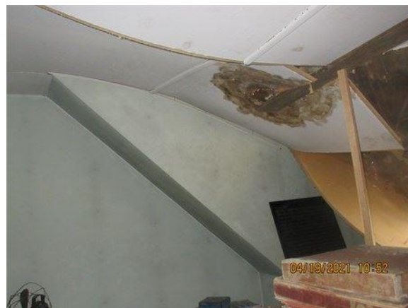
Vue des dégâts des infiltrations d'eau au r.d.c
