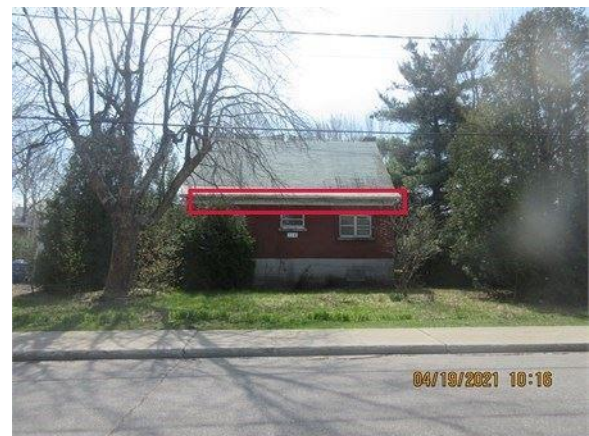
Vue du revêtement de bardeaux sur l'élévation avant
