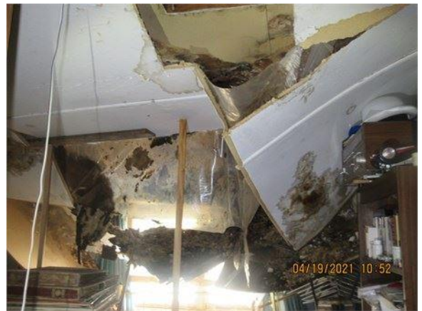
Vue des dégâts des infiltrations d'eau au 2ème étage
