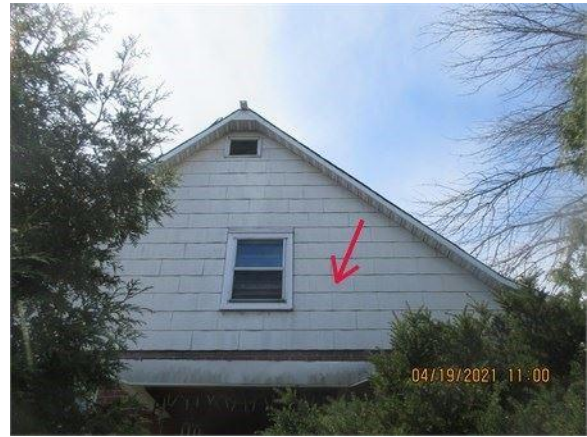
Vue du revêtement de bardeaux sur l'élévation gauche
