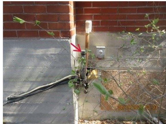
Vue d'ancien conduit d'alimentation pour un réservoir de mazout
