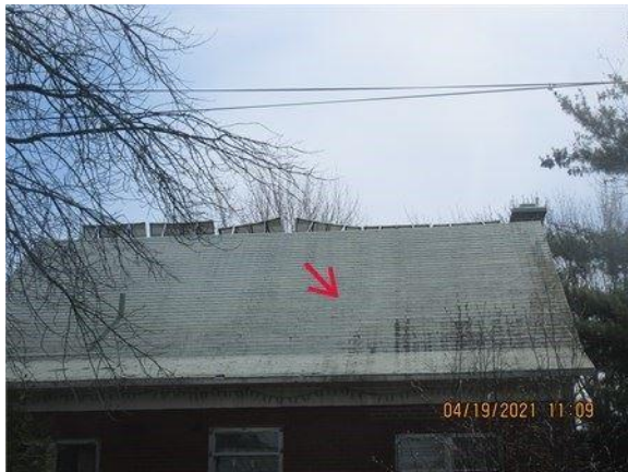
Vue des bardeaux d'asphalte de l'élévation avant
