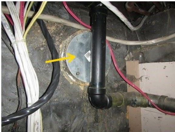
Cheminée condamnée dans le sous-sol, coin arrière droit
