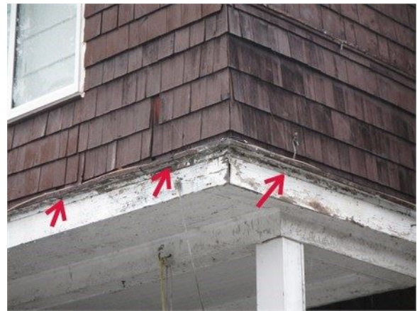
Le platelage du balcon est apparent à l'extérieur
