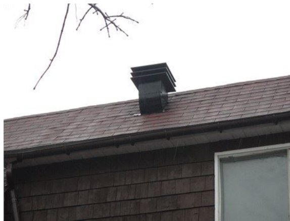
L'aérateur sur la pente arrière du toit principal
