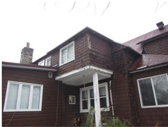
Extension construite sur un ancien balcon
