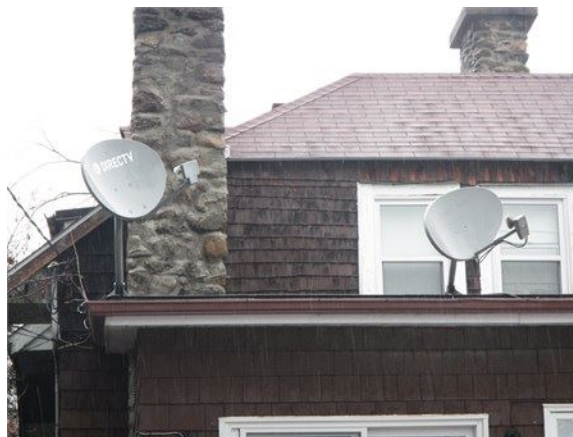
Les antennes sur le toit de l'extension arrière
