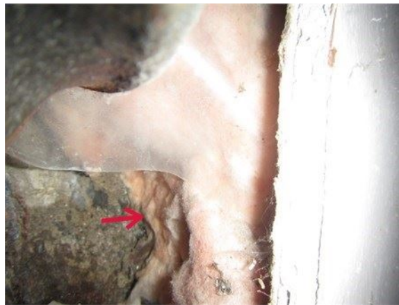
Laine minérale en contact avec un mur de fondation
