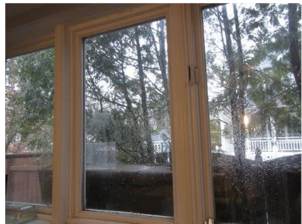
Fenêtre de la cuisine fabriquée autour de 1987
