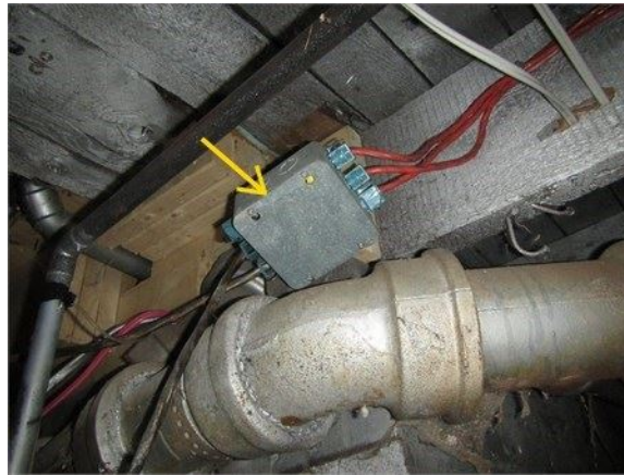
Boîte de jonction à fixer au sous-sol
