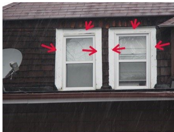
Vieux cadres en bois des fenêtres laissés sur place tout autour du bâtiment
