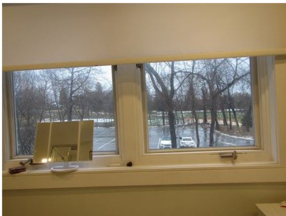
Vieille fenêtre en bois à l'intérieur et en PVC à l'extérieur fabriquée en 1987
