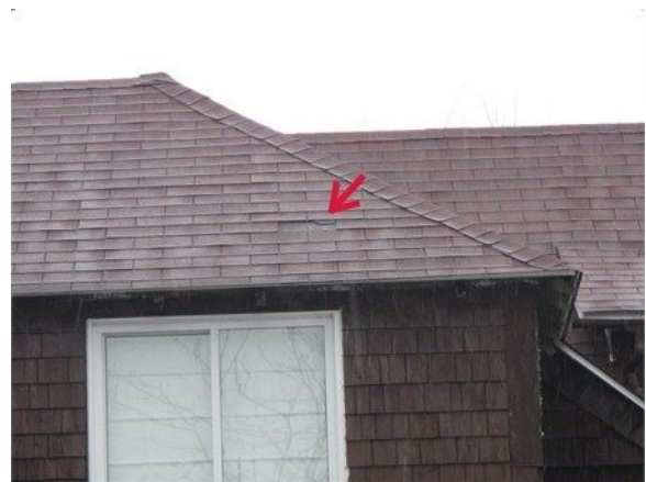
Bardeau arraché à remplacer à l'arrière
