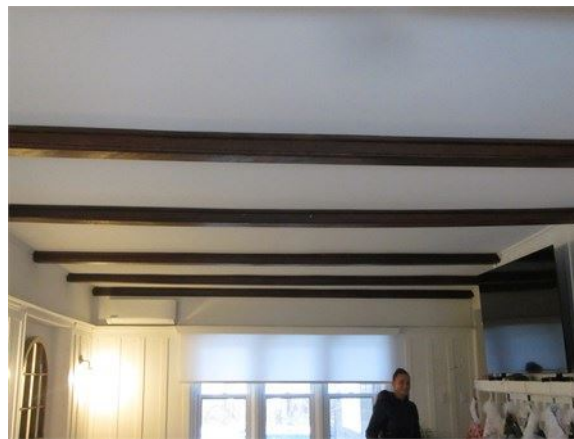
Les poutres au plafond du rez-de-chaussée
