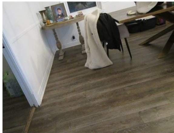
Le plancher de la salle à manger penche vers l'arrière
