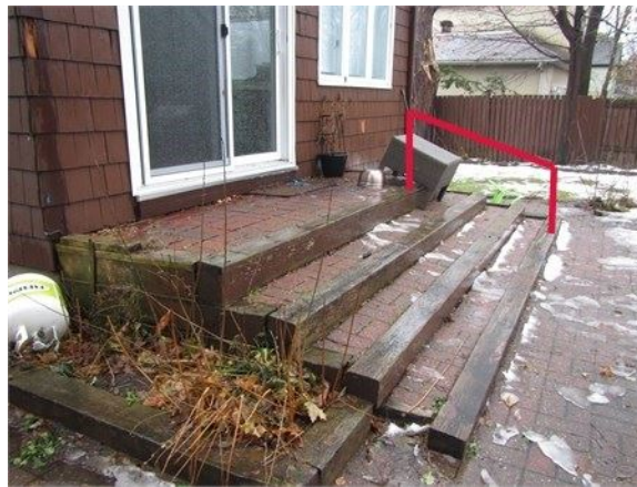
Installer une main courante dans l'escalier arrière
