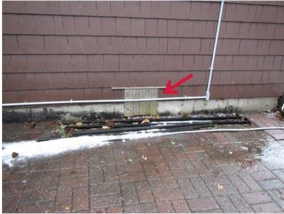
Fenêtre très près du sol (assurer un dégagement de 6 po avec le sol) et mal condamnée, mur latéral droit
