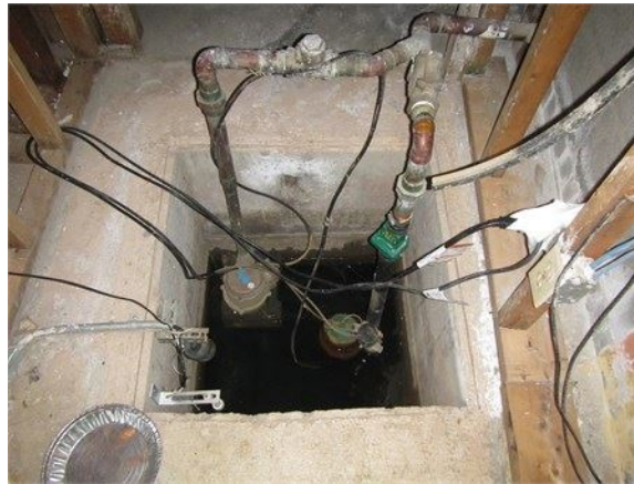
Installer un couvercle sur le puisard
