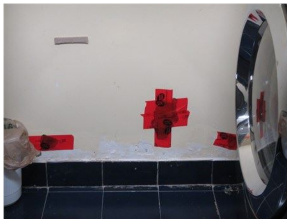
Ouvertures refermées dans la salle de lavage du sous-sol
