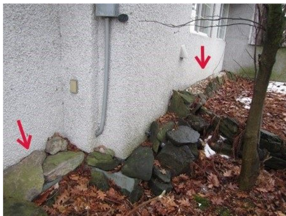
Niveau du sol trop haut sur le mur latéral gauche
