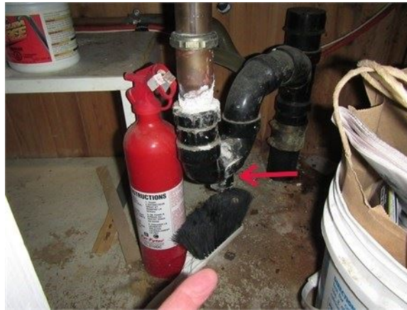
Surveiller l'évacuation sous la cive de lavage du garage
