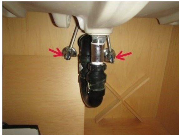
Exemple d'absence d'anti-béliers sous un lavabo
