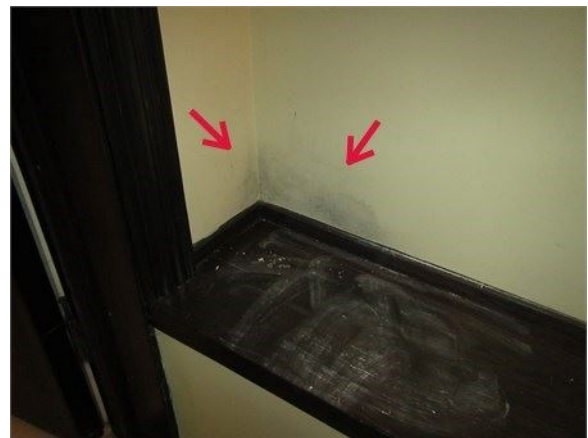
Taches qui pourraient comporter des moisissures dans un espace fini du sous-sol
