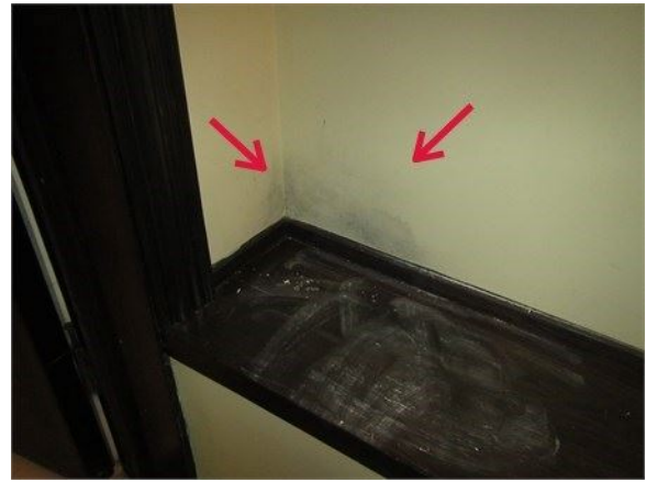
Autres taches qui pourraient comporter des moisissures dans le sous-sol fini
