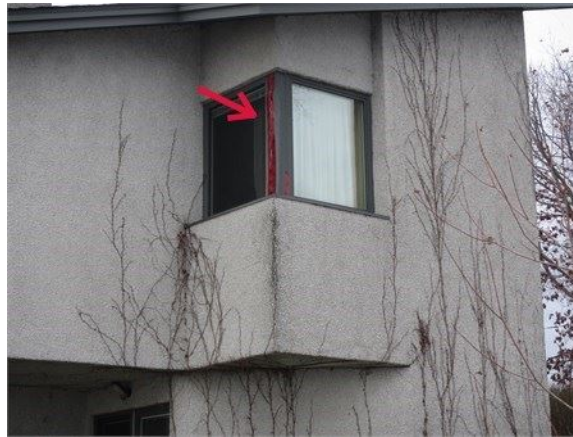
Finition à compléter sur un coin de fenêtre à l'étage
