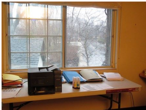
Fenêtre datée de 1981 à l'étage avec un vitrage cassé
