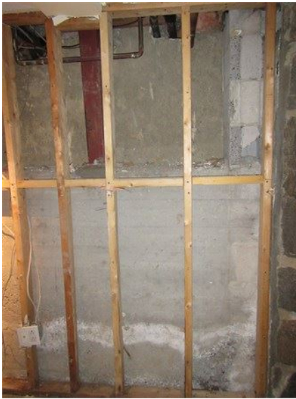
Travaux de sous-oeuvre pour rabaïsser le niveau du sous-sol derrière le sous-sol d'origine
