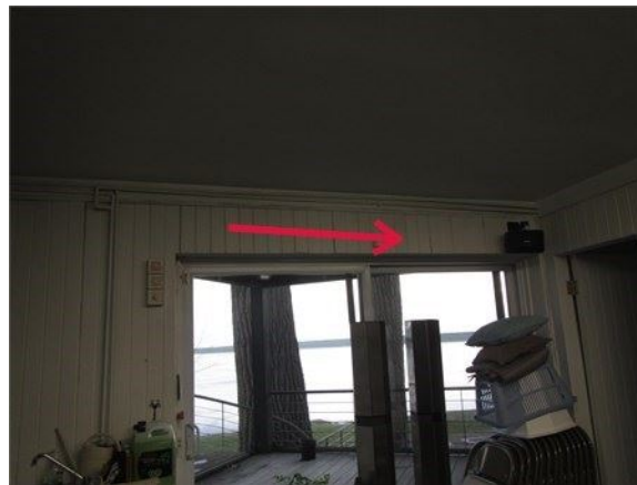
Garage affaissé vers l'arrière droit
