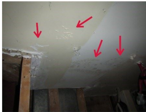
Taches qui pourraient comporter des moisissures au plafond du sous-sol qui a subi le pire de l'inondation, près du système de chauffage central
