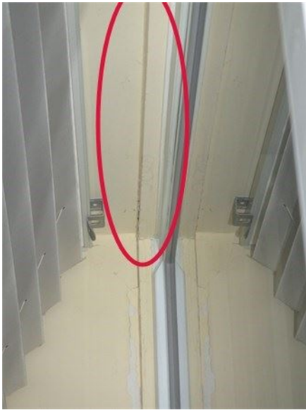
Taches d'infiltration d'eau au haut de la fenêtre latérale droite de la cuisine/dînette
