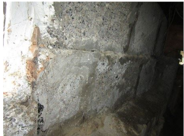
Déplacement de blocs de béton en guise d'exemple
