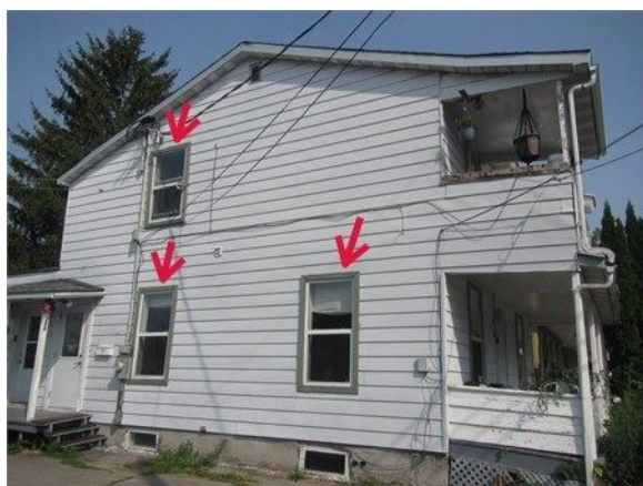
Absence de solins au-dessus des fenêtres et des moulures au-dessus des fenêtres
