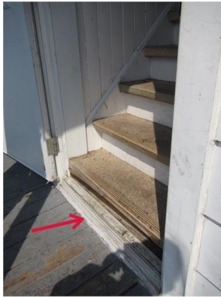
Absence de palier au bas de l'escalier de l'étage
