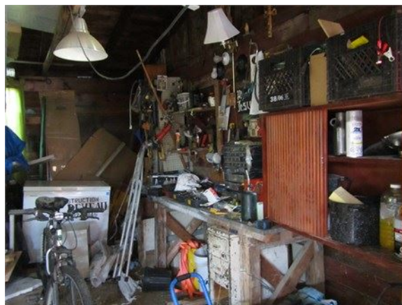
L'encombrement a limité l'inspection
