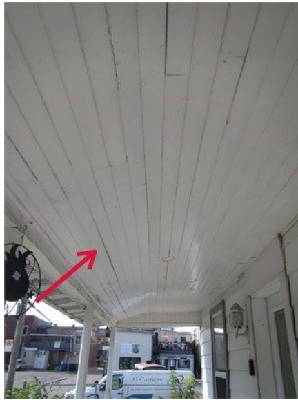
Ventiler la sous-face de la galerie avant
