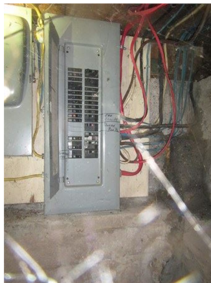
Faire identifier les disjoncteurs qui ne le sont pas
