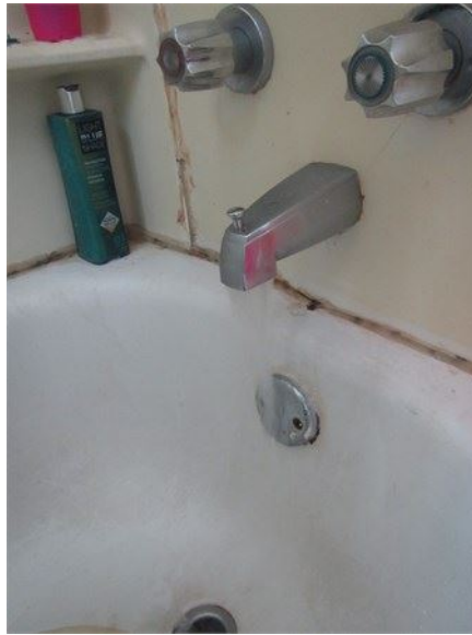
Faible pression d'eau dans la baignoire de l'étage
