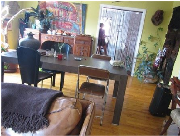
Le plancher de la salle à manger/séjour du rez-de-chaussée penche vers la droite
