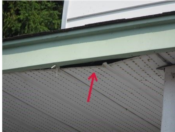
Fixer les soffites en place
