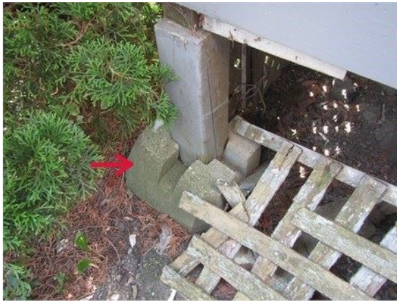
Pilier préfabriqué posé directement sur le sol : déplacements lors de gel et de dégel
