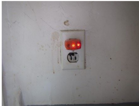
Exemple de prise dont les contacts sont inversés
