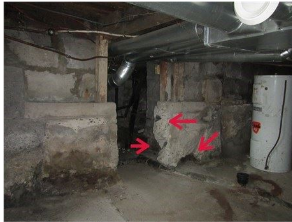
Consolider le béton cyclopéen de part et d'autre de l'ouverture vers l'arrière
