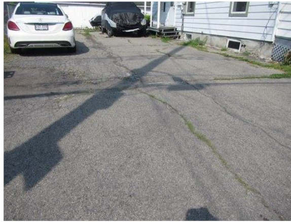
Asphalte fissuré
