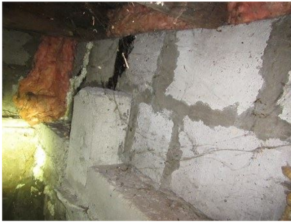
Autres blocs de béton déplacés à faire voir par un ingénieur en structure et fondations
