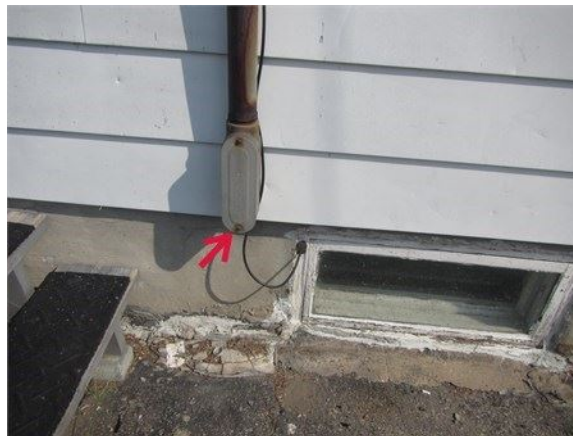
Faire percer la base du mât électrique
