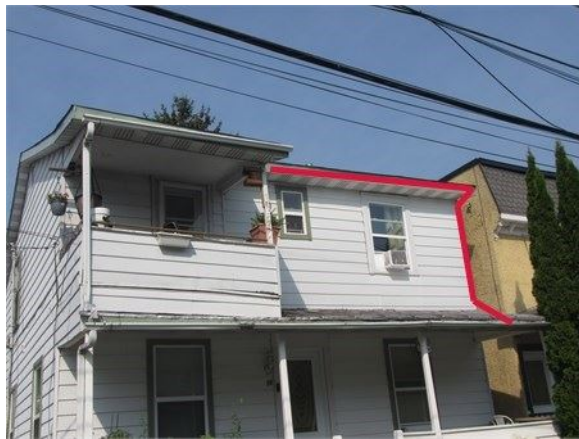
Installer une gouttière sur la pente avant de la toiture principale
