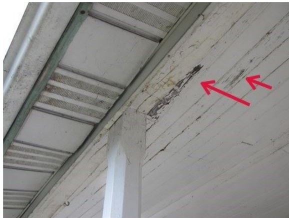
Taches d'infiltration d'eau dans les soffites de bois sous le balcon de l'étage
