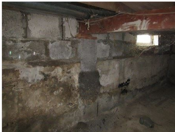
Blocs de béton au-dessus de murs en béton cyclopéen
