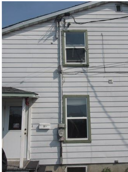
Ajouter des brides de fixation au mât électrique du rez-de-chaussée
