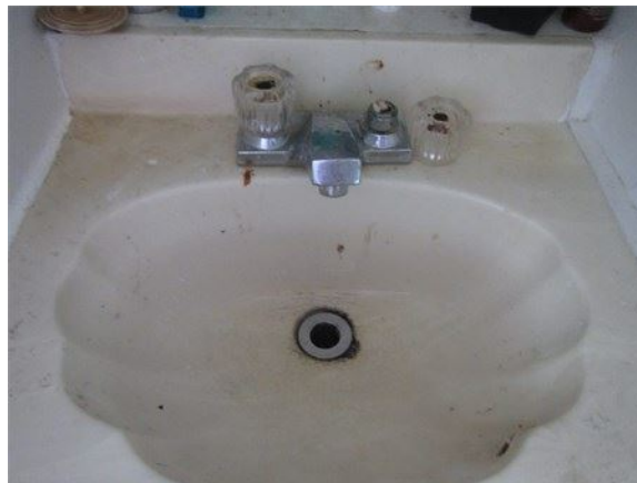
Lavabo fissuré à l'étage
