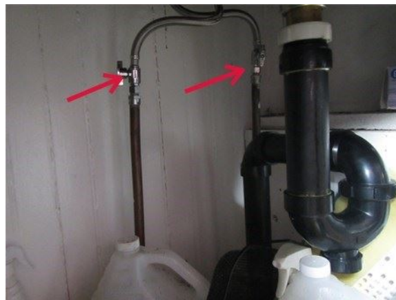
Exemple d'absence d'anti-béliers sous un appareil de plomberie
