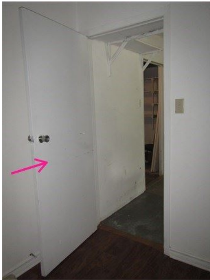
La porte entre la maison et le garage : Installer un ferme-porte et un coupe-froid tout autour de la porte y compris sur le seuil
