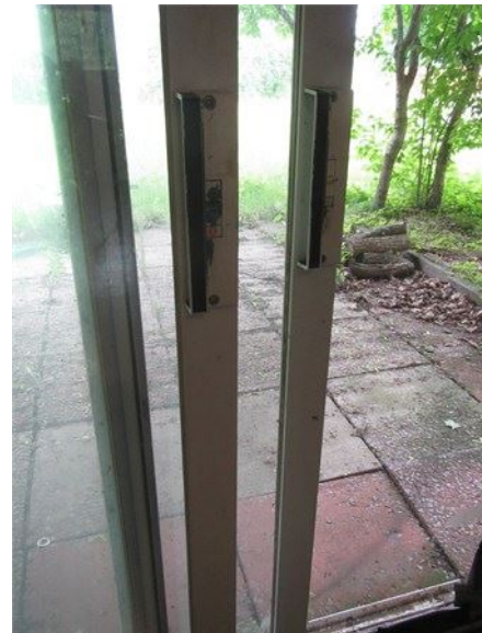
Les sections de la porte-fenêtre sont à simple vitrage, ce qui est moins performant
