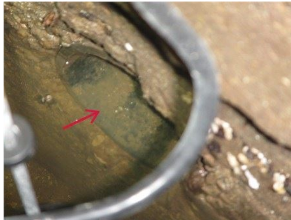
Le drain qui se trouve sur la paroi avant du puisard / Au besoin, ajuster la flotte de la pompe pour que le niveau de l'eau soit plus bas que le drain
