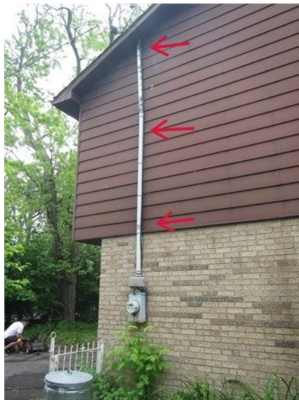
Ajouter des fixations au mât électrique
