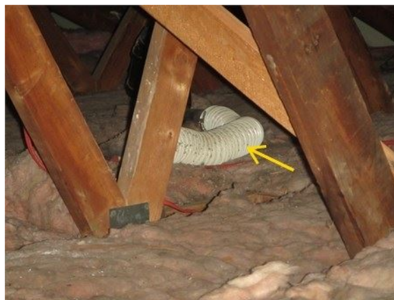
Conduit d'extraction à isoler. S'assurer que le conduit aboutit à l'extérieur par le biais d'un registre à clapet
