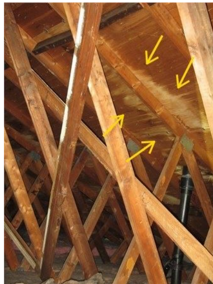
Traces anciennes à surveiller sur la pente arrière
