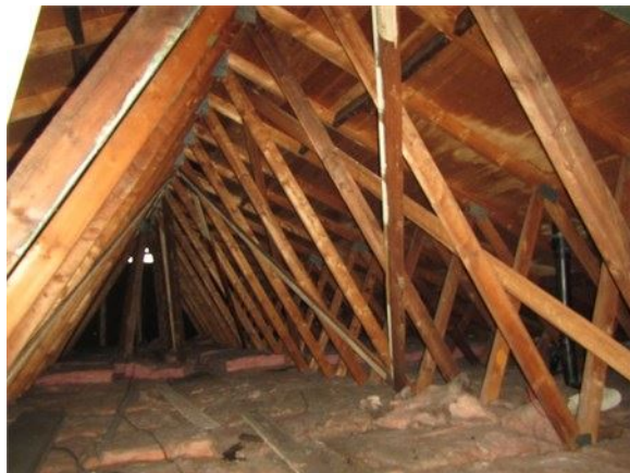
Structure de toit préfabriquée
