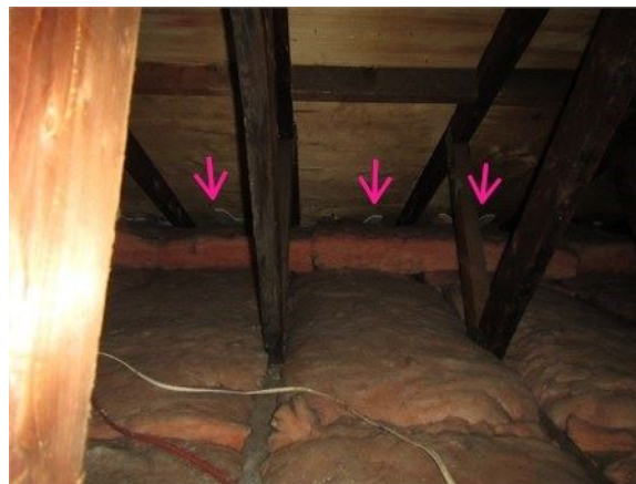
Des déflecteurs ont été installés sur les rives au bas des pentes du toit
