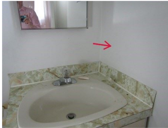
Pas de prise dans la salle de bains des maîtres
