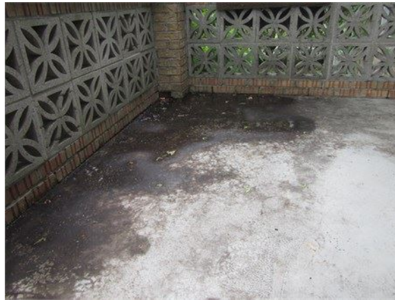
Rétentions d'eau sur le perron avant
