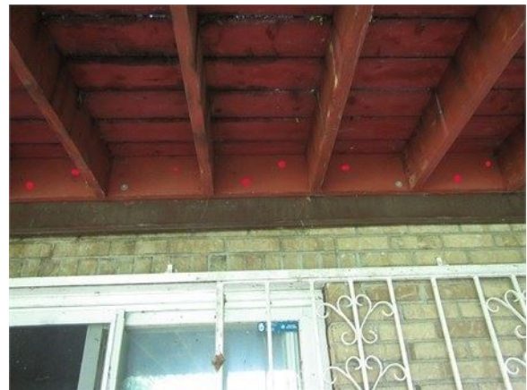
Ajouter des boulons entre les solives de la terrasse pour solidifier la structure au mur arrière
