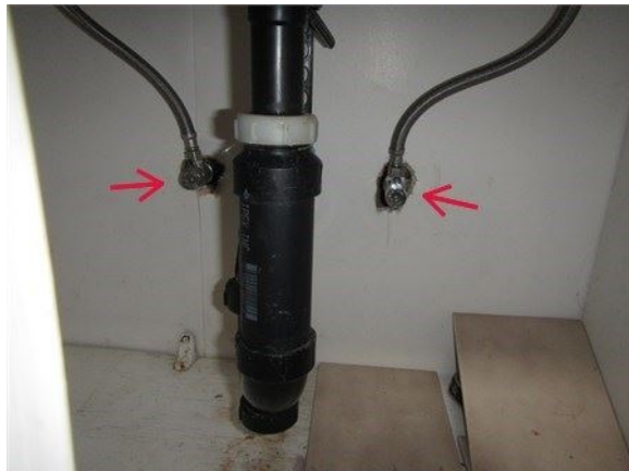
Absence d'anti-béliers sous un appareil de plomberie en guise d'exemple
