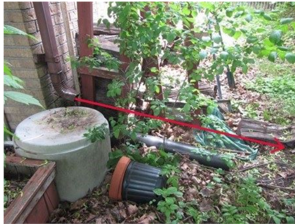
Installer des exutoires pour éloigner les eaux des gouttières des murs extérieurs
