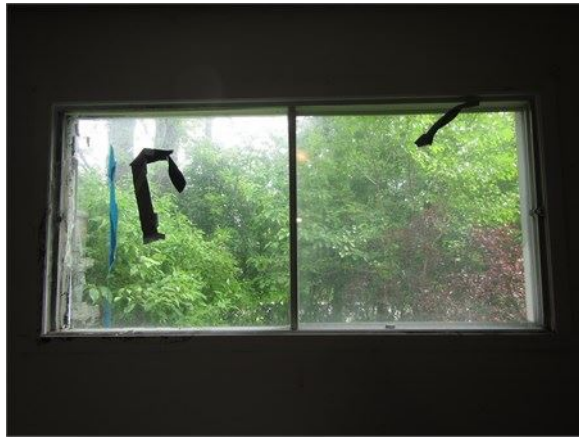
Exemple de fenêtre coulissante âgée à remplacer au rez-de-jardin
