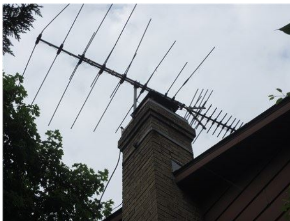
Antenne fixée à la cheminée
