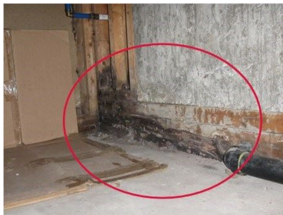
Traces d'infiltration d'eau sur le coin avant droit de l'espace sous l'escalier du sous-sol à expertiser
