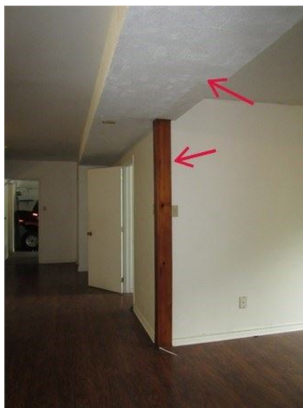
Poutre et poteau probables sous les revêtements de finition au rez-de-jardin
