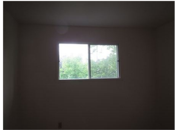
Exemple de fenêtre de chambre au rez-de-chaussée à remplacer
