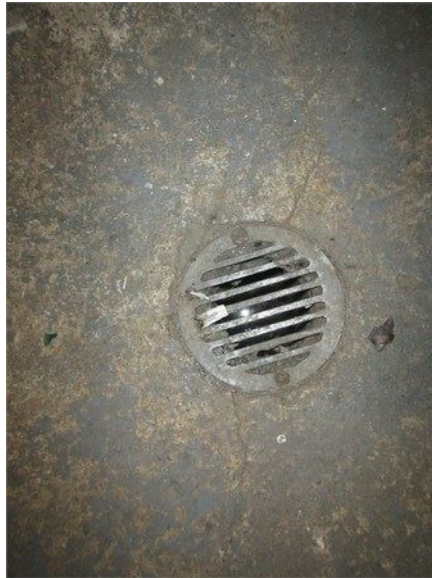
Le drain de plancher au sous-sol
