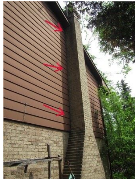
Sceller la jonction entre les divers matériaux comme ici avec la cheminée
