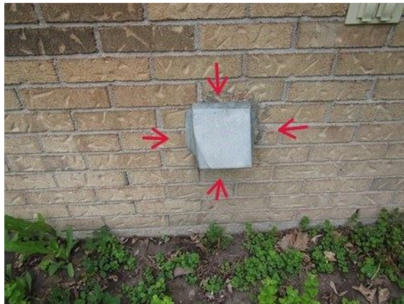
Sceller le pourtour des registres d'évacuation d'air sur les murs extérieurs après les avoir fixé au mur
