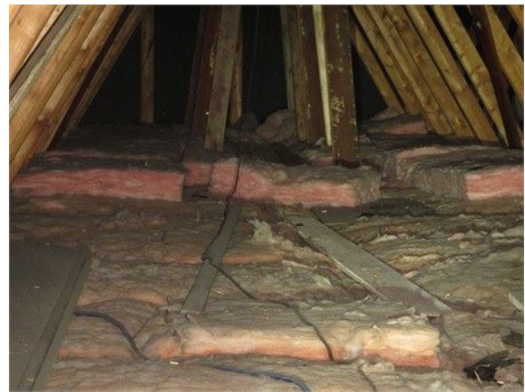
Par endroits, de l'isolant a été ajouté
