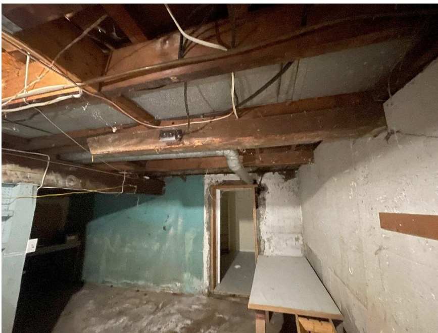
Exemple de poutrelle du plancher non-continue
