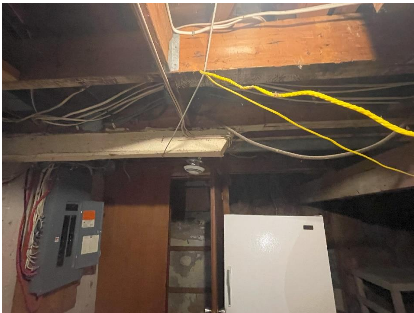
Exemple de poutrelle du plancher non-continue
