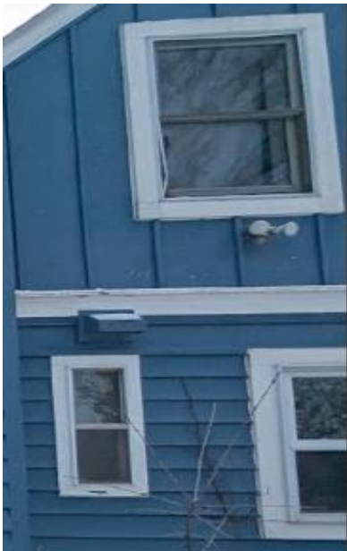
Exemple de manque du solin dessus fenêtre Exemple du cadre de fenêtre magané
