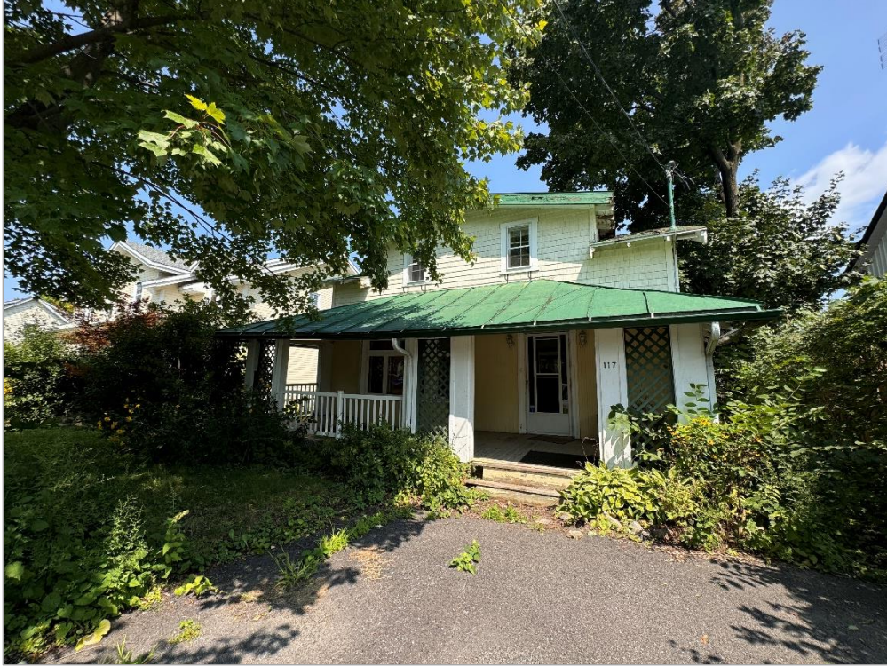
Vue avant du bâtiment
