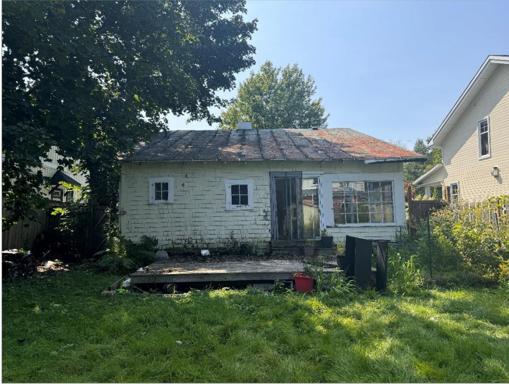
Vue arrière du bâtiment
