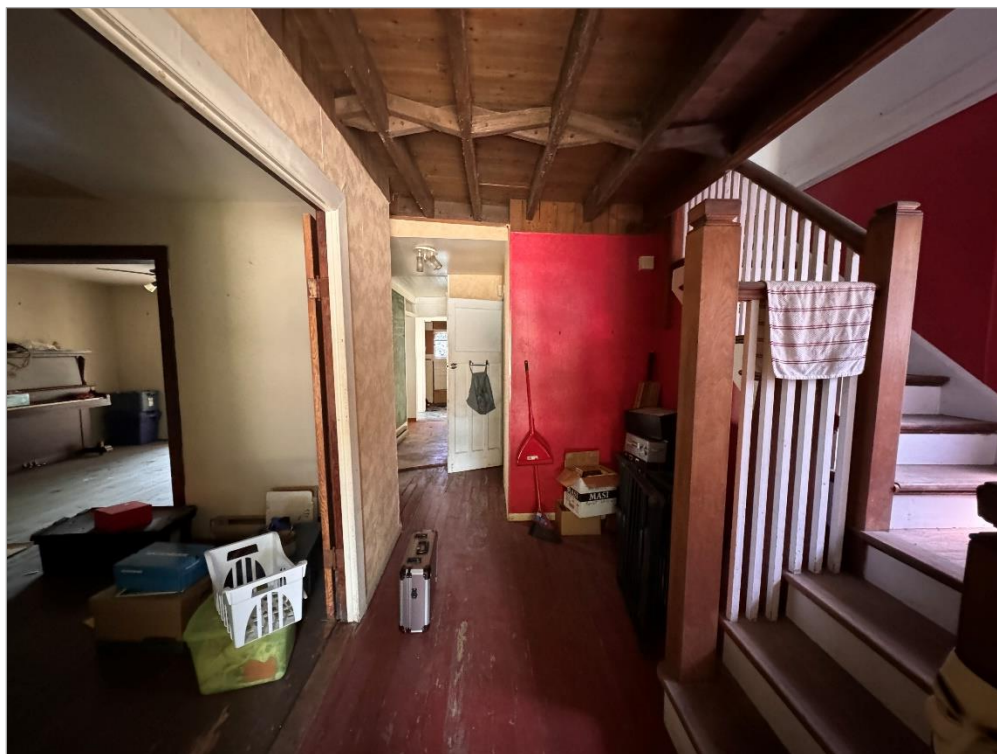
Corridor du rez-de-chaussée et escalier menant à l'étage
