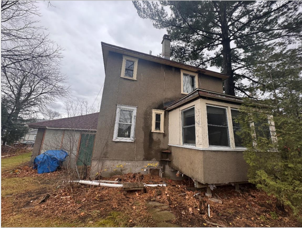
Vue arrière du bâtiment
