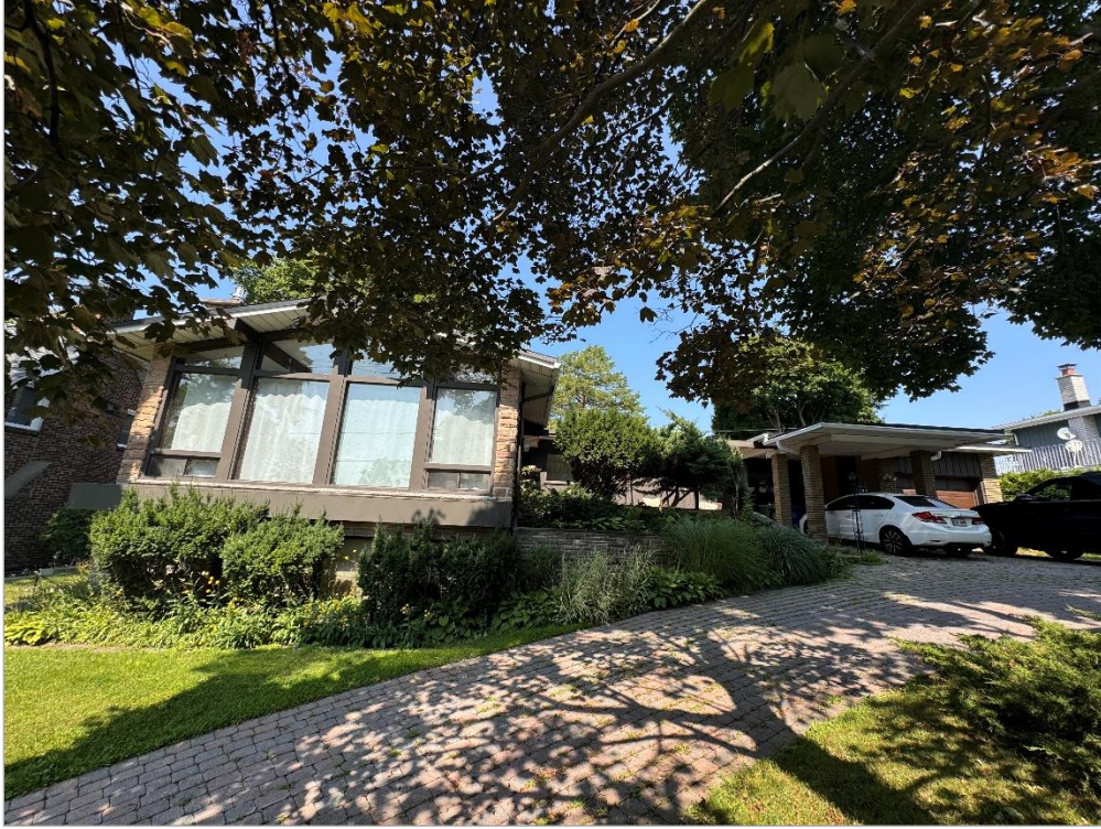
Façade du bâtiment
