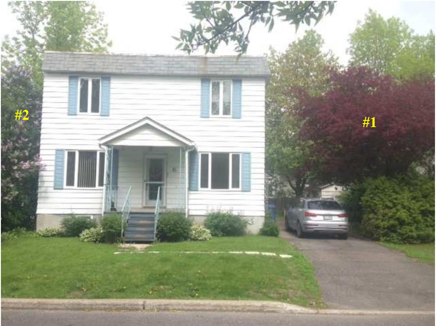
Photo #1 : Vue d'ensemble au 45 av. Saint-Joachim.
