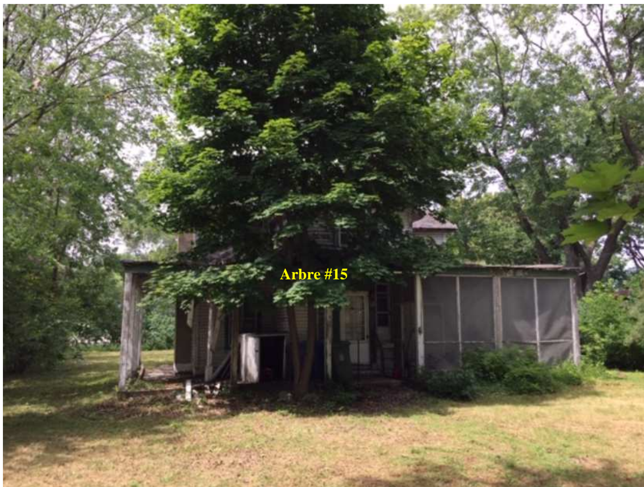
Photo #7 : Bâtiment existant et érable de Norvège à abattre.
