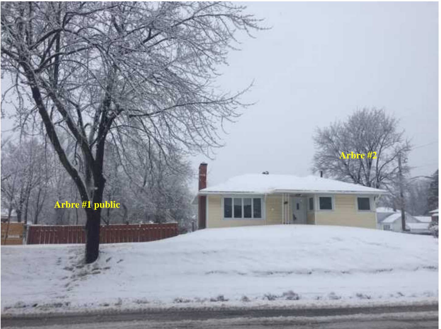
Photo #1 : Vue d'ensemble au 347 avenue Saint-Louis.
