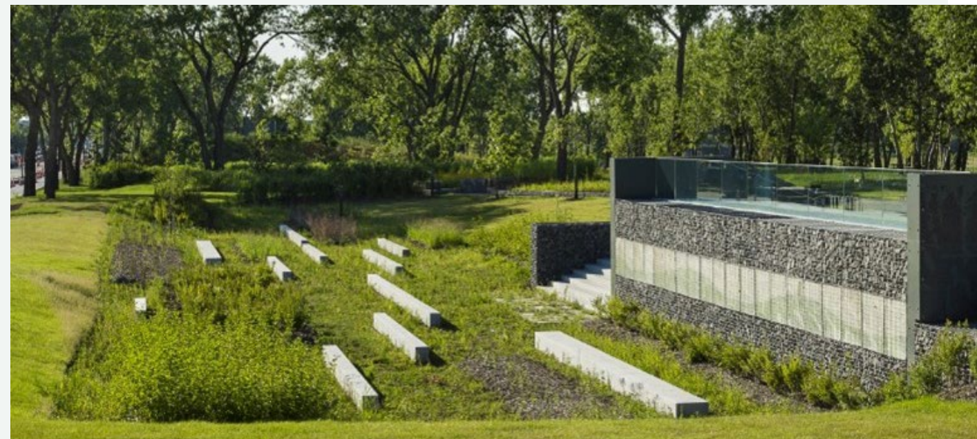
Exemple d'intégration réussie de bassins de rétention au parc Frédéric-Back (quartier Saint-Michel, ville de Montréal).
